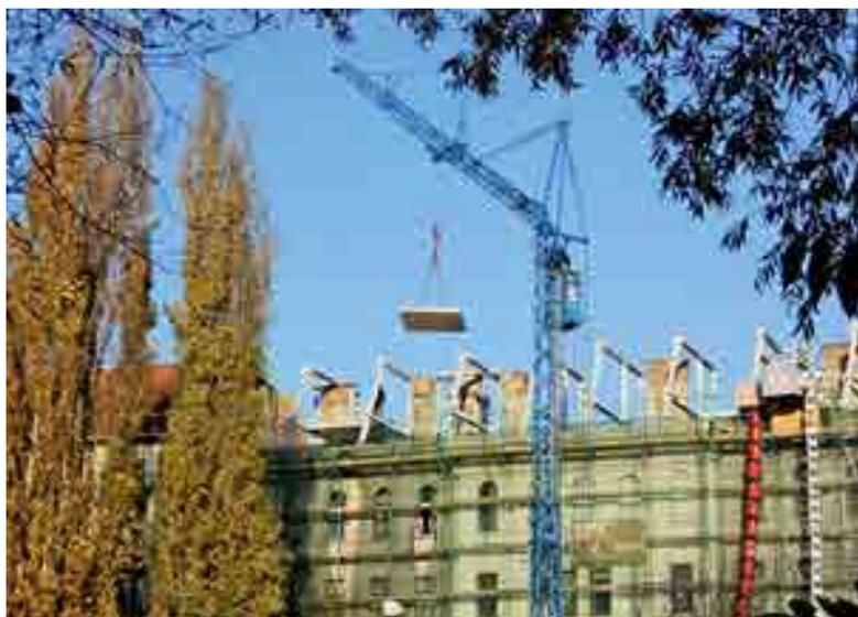
Die in weiten Teilen systematisierte und vorelementierte Holzbauweise ermöglicht kurze Bauzeiten mit geringen Lärm- und Staubemissionen
