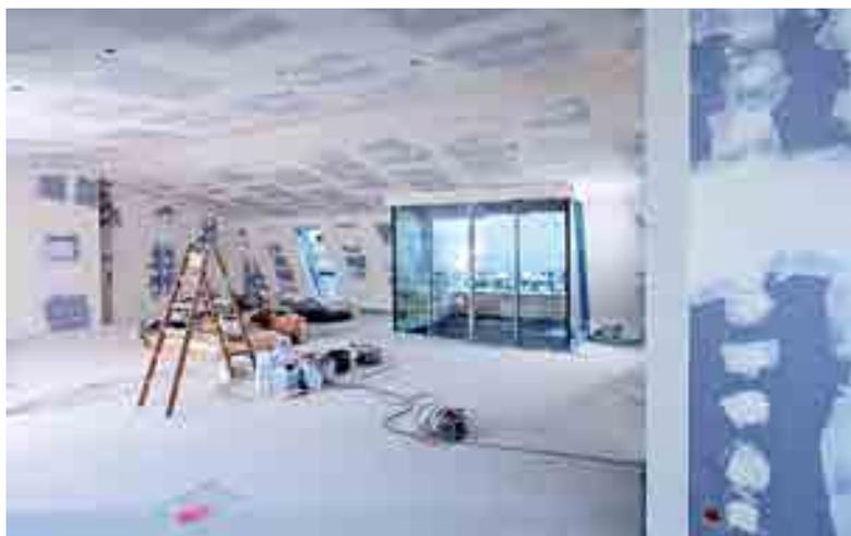
Sämtliche Massivholzwände des Dachgeschosses sind mit Trockenbauplatten verkleidet
