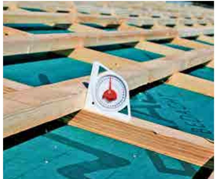
Mit dem 7-Grad-Dachsystem können Dachdeckungen im Dachneigungsbereich von 7°-12° ausgeführt werden
