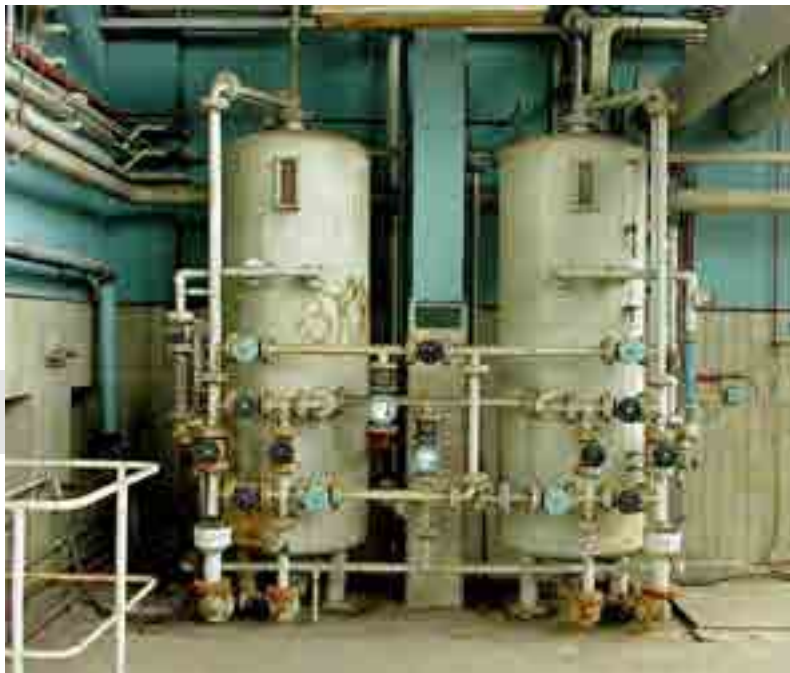
Ein grundsätzliches Nutzungsverbot besteht aktuell nur für Öl- und Gaskessel, die mehr als 30 Jahre alt sind.
