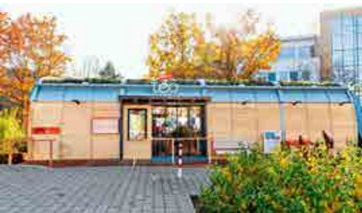
Lebensmittelshop-Prototyp in Fulda: „teo“ sticht hervor durch seine charakteristische Holzfassade und sein nachhaltig begrüntes Dach.
