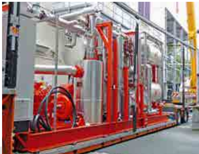
Solche Großwärmepumpen können Netze, aber auch direkt große Immobilien versorgen.
