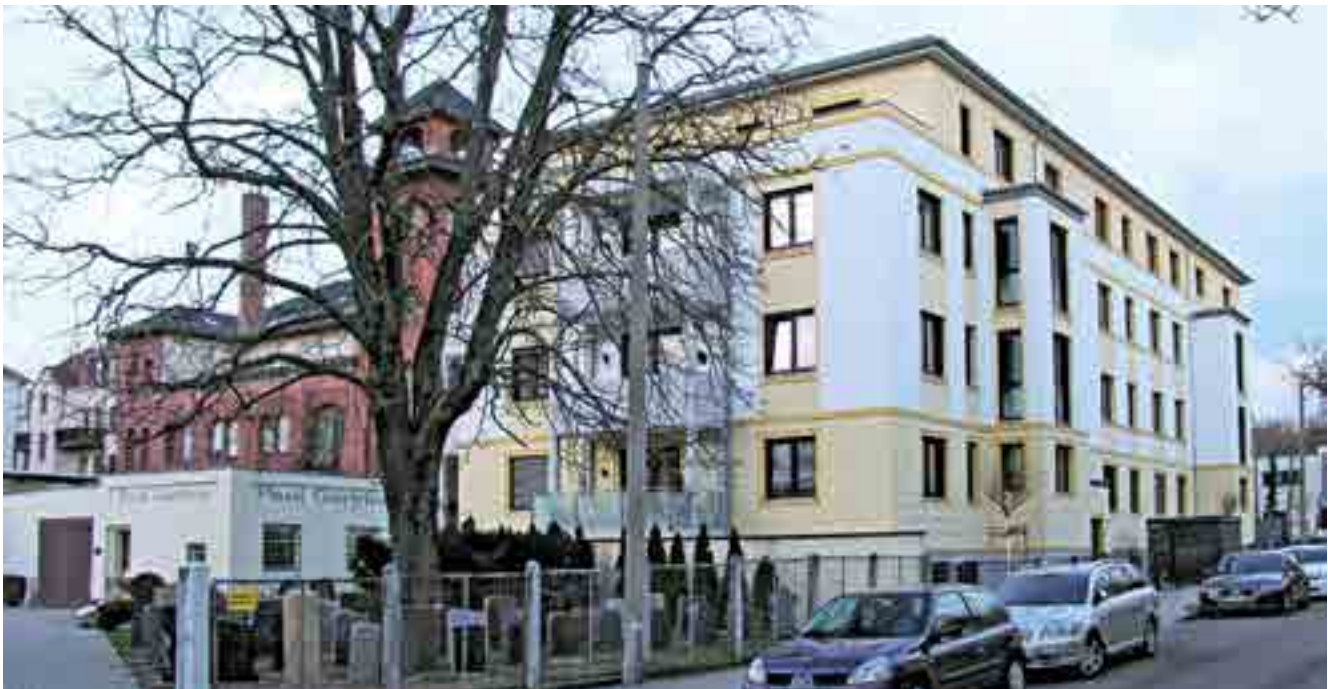
Oben: Michael Suhr: „KfW-40-Standard ist ausgereizt.“ Unten: Atrium-Objekt St. Florian in Leipzig, links die namensgebende Feuerwache. Es kommt komplett ohne Außendämmung aus. Beheizt wird es mit Flüssiggas und Solarthermie.
