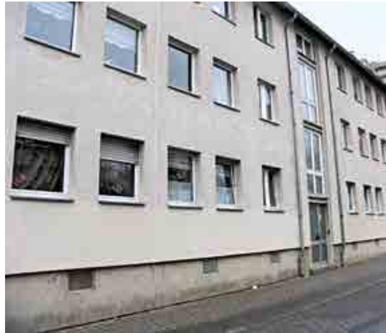
Nur Schönheitsfehler? Gedämmte und mit der Zeit vergraute Fassade.
