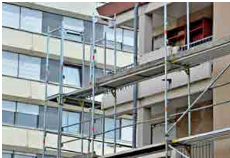
Fenster- und Außentürsanierung zählt zu den erleichterten KfW-Fördermaßnahmen.
