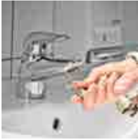
1 Entfernen des Perlators
