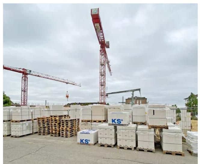
**Oben:** Diese Wohngebäude werden komplett aus Kalksandstein gebaut. Lediglich die Geschossdecken und die Kellerplatte werden in Stahlbeton ausgeführt.
