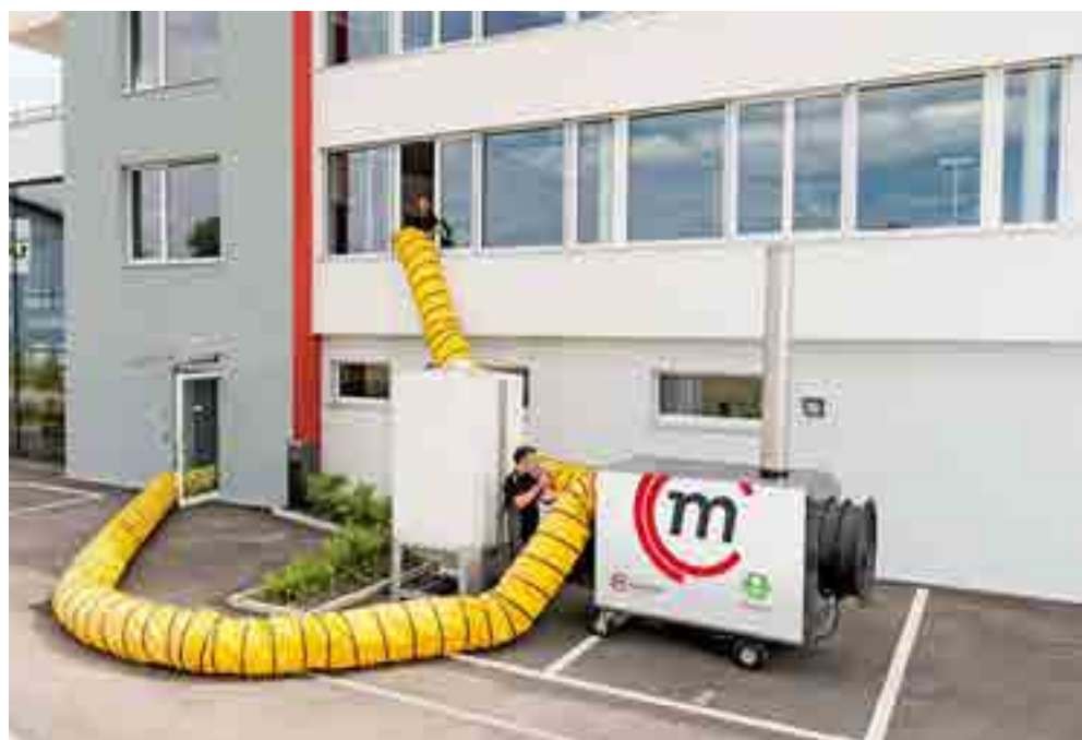
Einsatz einer mobilen Heizquelle, hier mit Pellets betrieben, während einer Bestandssanierung.
