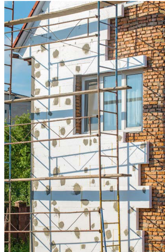
Eine moderne Dämmung der Gebäudehülle ist bei vielen Bestandsimmobilien der erste Schritt zur Umsetzung der Wärmewende.
