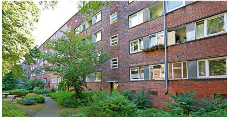
Links: In Mümmelmannsberg werden auch die Außenanlagen neu gestaltet.
