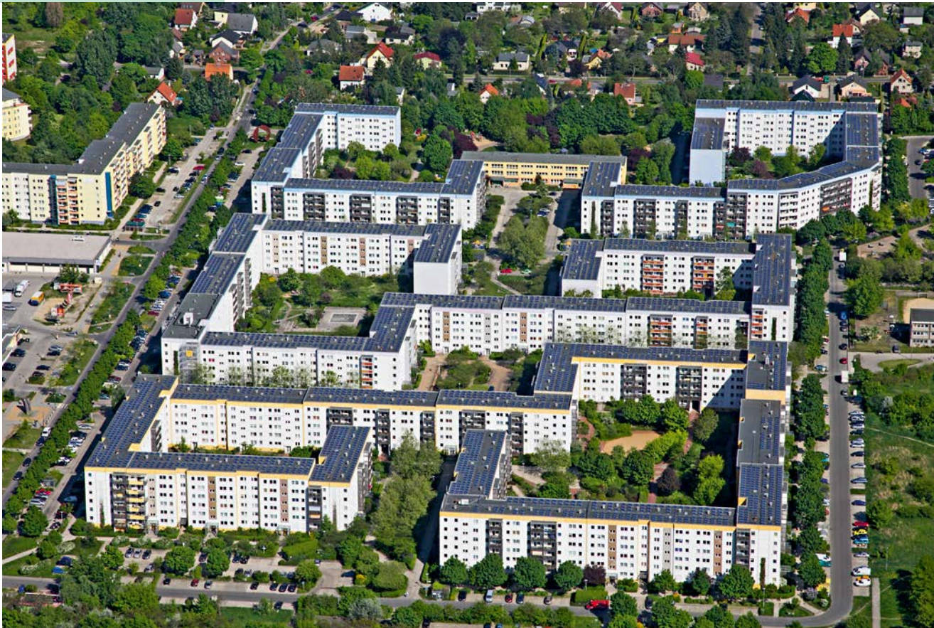
Sonnenstrom für ein Quartier: Im Gelben Viertel in Berlin-Hellersdorf hat die Stadt und Land Wohnbauten-Gesellschaft die größte PV-Anlage Deutschlands auf 50 Wohngebäuden umgesetzt. Mit 8.000 Solarelementen werden bis zu 50 % der benötigten Energie der 3.000 Mietparteien mit Sonnenenergie erzeugt
