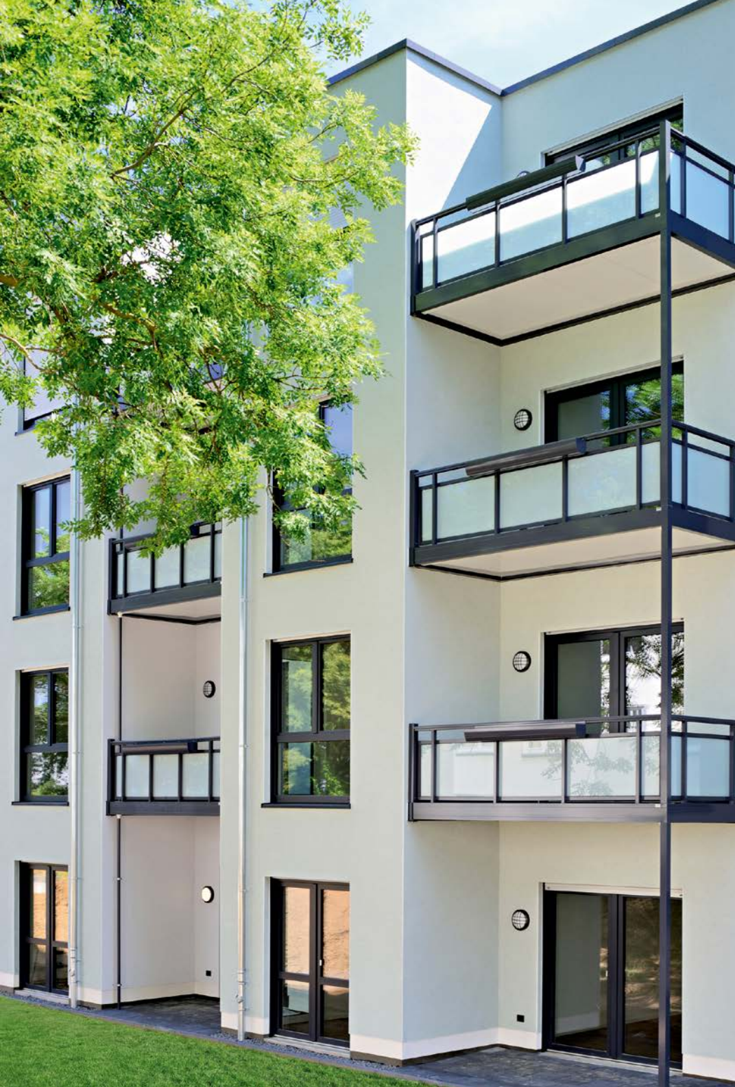
Insgesamt 180 Raummodule mit einem sehr hohen Vorfertigungsgrad sorgten für eine Reduzierung der Bauzeit der drei Häuser auf 1,5 Jahre
