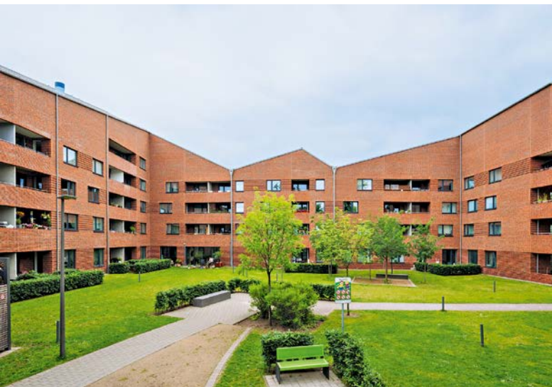
Sanierte und erweiterte Altbauten sowie Ersatz- und ergänzende Neubauten prägen das Weltquartier in Hamburg-Wilhelmsburg
