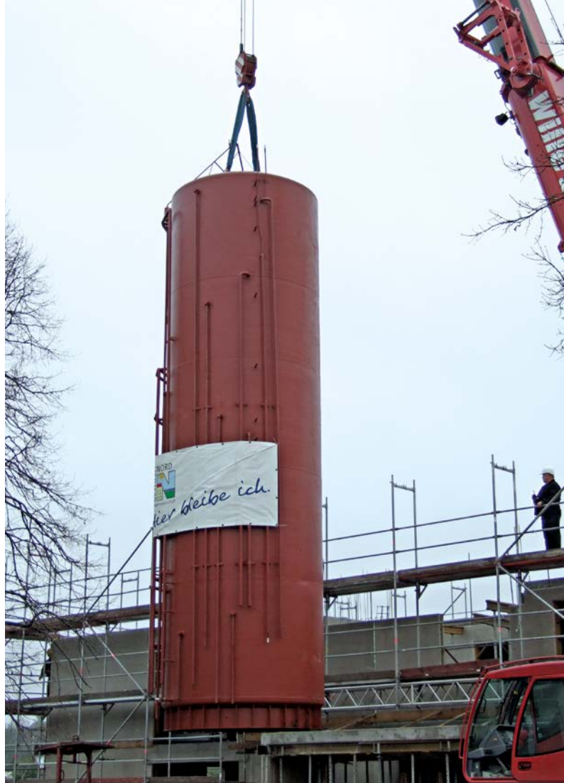
Das „Herzstück“ eines Sonnenhauses nach dem Konzept des Schweizer Josef Jenni ist ein großer Wassertank innerhalb des Gebäudes
