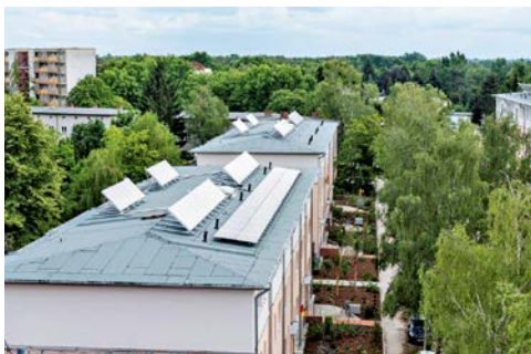
Bestandsgebäude der Märkischen Scholle in der Schwelmer Straße
