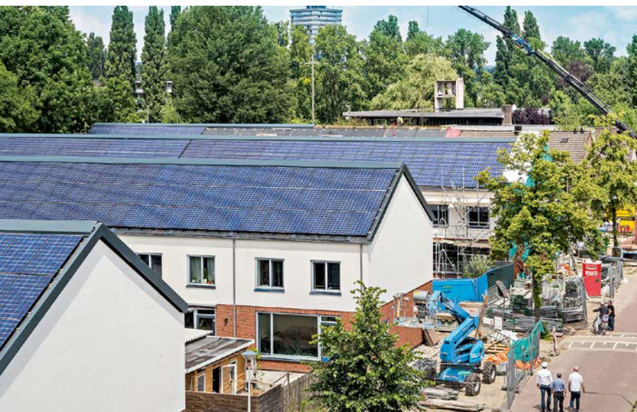
Serielles Sanieren, wie hier im niederländischen Original in Arnhem, soll zukünftig klimaneutrales Wohnen im Bestand bezahlbar machen
