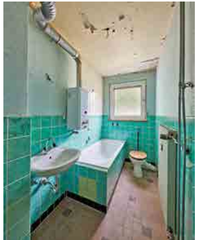
Das Pilotbad in Recklinghausen vor der Sanierung
