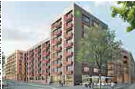
An der Ecke Schultzweg/Norderstraße in Hammerbrook entsteht ein Wohnquartier für 650 Menschen
