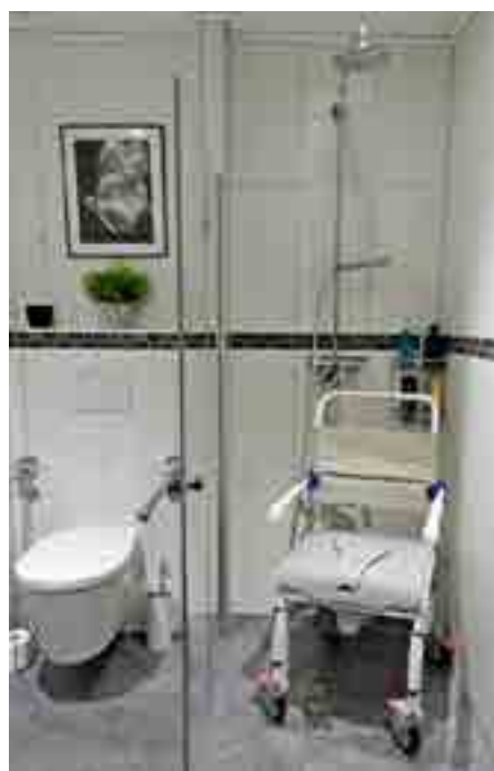
Einbau einer Bodenablaufpumpe für die Nutzung eines Rollstuhles
