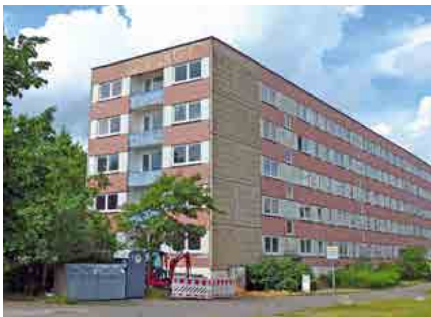
So sah der Wohnblock in der Neubrandenburger Straße im Stadtteil Schwerin-Neu Zippendorf vor der Sanierung aus
