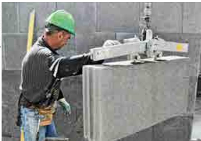
Dank spezieller Versetzgeräte und passender Ergänzungsprodukte entsteht ein Quadratmeter Mauerwerk in 0,44 Stunden
