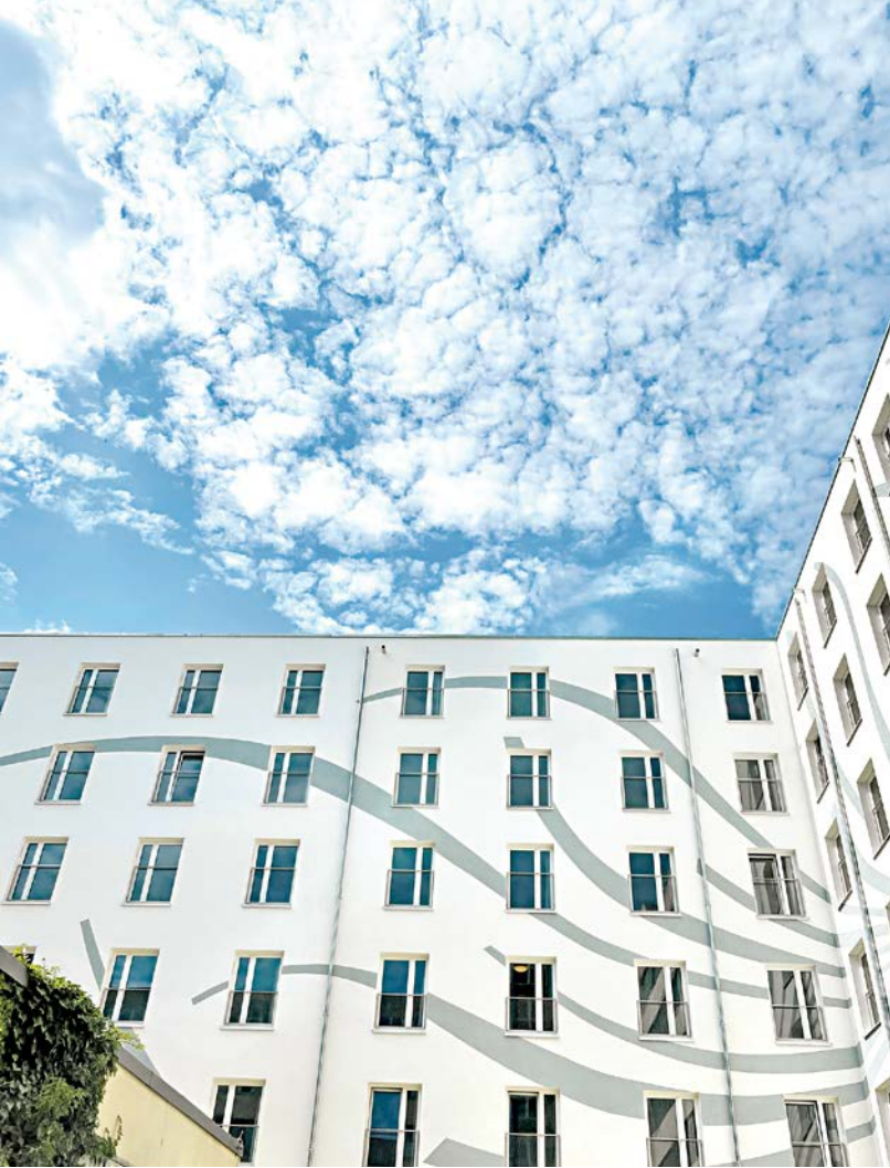
Die Berlinovo baute 2021 eine siebengeschossige Apartmentanlage für 442 Studenten in Modulbauweise. Das gesamte Duschwasser wird nach Aufbereitung zur WC-Spülung verwendet. Zugleich wird Wärme zurückgewonnen und für die Trinkwassererwärmung eingesetzt
