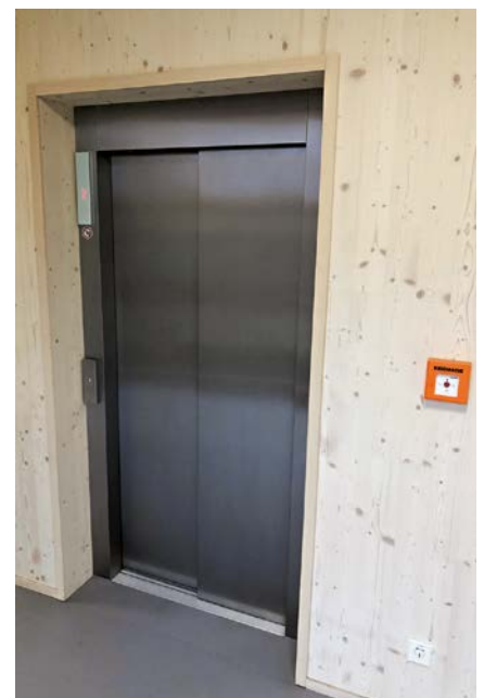
Holzbau macht Schule: Der Aufzugschacht besteht vollständig aus dem nachwachsenden Rohstoff
