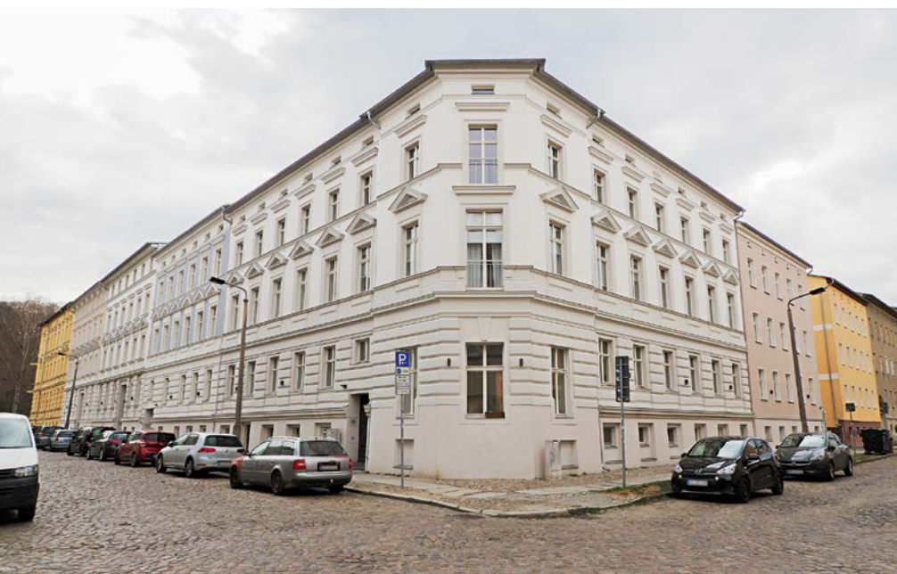
Die Sanierung der stadtbildprägenden Häuser in Eberswalde, die in den Jahren 1897 bis 1901 errichtet wurden, hat insgesamt 7 Mio. € gekostet. Geschaffen wurden 33 moderne Wohnungen
