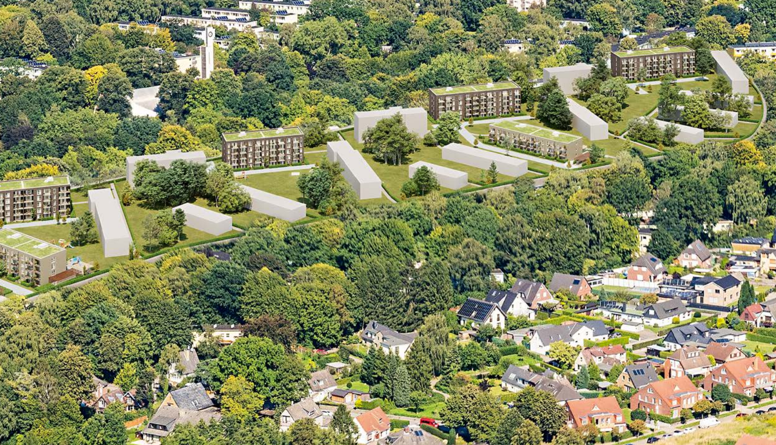
Die Visualisierung zeigt die sieben neuen Gebäude des Projekts „Luisenhof“ der mgf zwischen dem historischen Bestand (grau). Am oberen Rand ist die Erlöserkirche zu sehen, ein wichtiger Mittelpunkt der Gartenstadt
