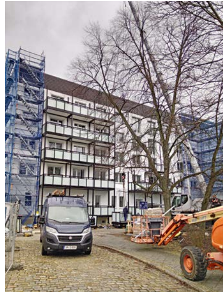
Der Innenhof während der Bauarbeiten. Zur Wohnqualität tragen die großzügigen Balkone bei
