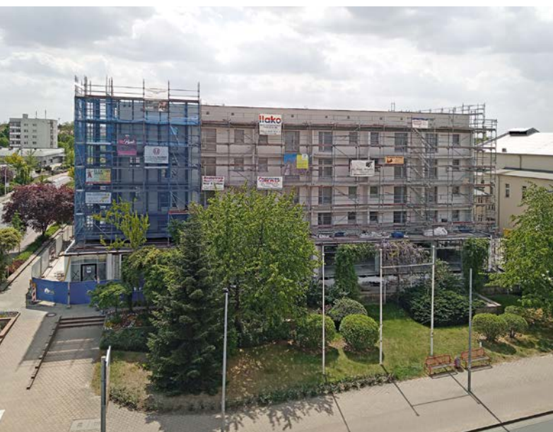
Zehn Jahre lang stand der Plattenbau der Baureihe P2 im Zentrum von Forst (Lausitz) leer, bevor die Umbauarbeiten begannen
