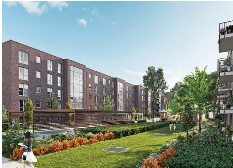
Die Fassaden der drei- bis fünfgeschossigen Neubauten sind im Gegensatz zum verputzten Bestand mit Vollverblendern verkleidet. Trotz der Ausstattung mit Fahrstühlen, zahlreicher barrierefreier Wohnungen und Balkonen liegt die Anfangsmiete bei 6,70 €/m 2
