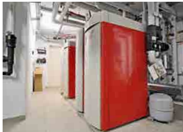
...im Haus mit den Familienwohnungen kommt eine Kaskade mit zwei Wärmeerzeugern zum Einsatz
