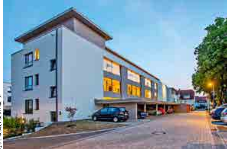
Innovativ, attraktiv und bezahlbar: Das Ensemble aus sieben Mehrfamilienhäusern, von denen sechs durch ein gläsernes Atrium und Laubengänge miteinander verbunden sind, erhielt Ende Mai 2018 den Thüringer Preis der Wohnungswirtschaft
