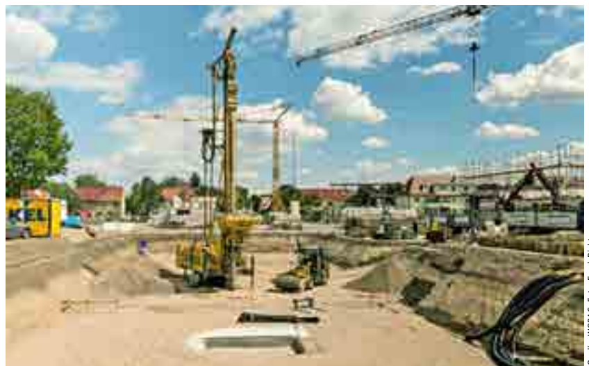
Baugrundstabilisierung durch das Einbringen von 96 Rüttel-Stopf-Säulen aus Schotter unter das Planum für die Bodenplatte der Tiefgarage von Haus I im September 2015
