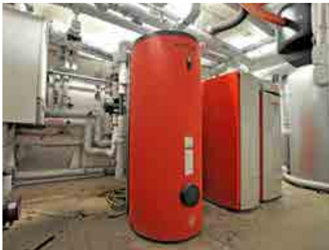
...im Haus mit den Familienwohnungen kommt eine Kaskade mit zwei Wärmeerzeugern zum Einsatz
