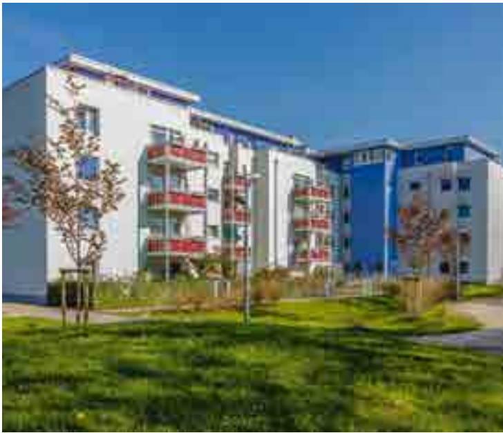
Stadtumbau in Gelsenkirchen-Tossehof. Die ggw-Anlage Kopernikusstraße 6-14 wurde völlig erneuert: Die Häuser Kopernikusstraße 2-4 wurden komplett nieder-geleegt, die Häuser 6-14 auf vier Etagen zurückgebaut und mit einem neuen Staffelgeschoss versehen. Fotos nach dem Umbau und während des Umbauprozesses
