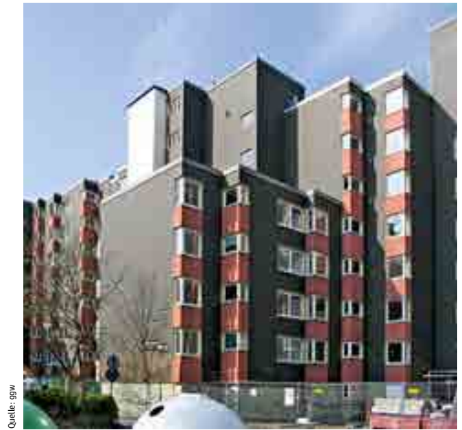
Stadtumbau in Gelsenkirchen-Tossehof. Die ggw-Anlage Kopernikusstraße 6-14 wurde völlig erneuert: Die Häuser Kopernikusstraße 2-4 wurden komplett nieder-geleegt, die Häuser 6-14 auf vier Etagen zurückgebaut und mit einem neuen Staffelgeschoss versehen. Fotos nach dem Umbau und während des Umbauprozesses
