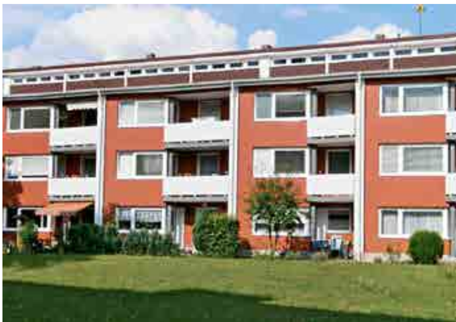
Basismodernisierung in der Ossietzkystraße im Stadtteil Nürnberg-Sünderbühl
