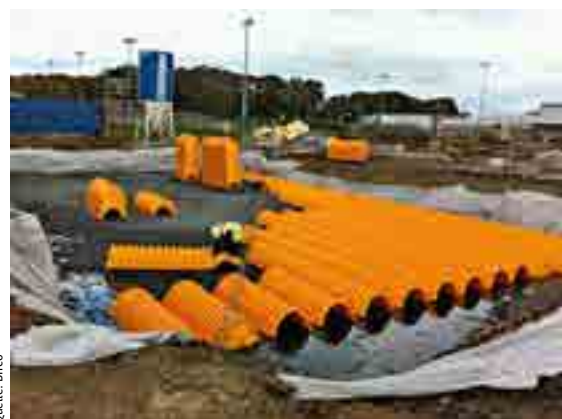
Einbausituation der neuen Rigolentunnel
