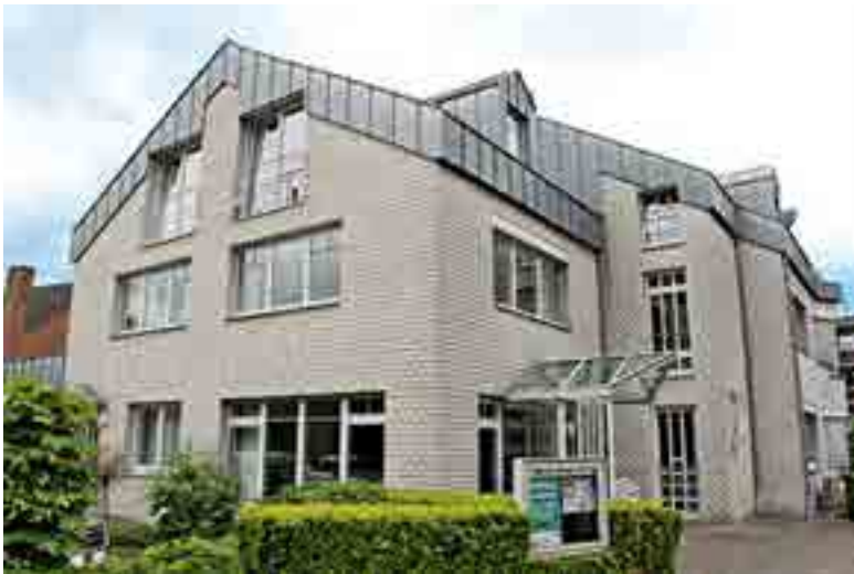
Die Unterrichtsstunden werden teilweise im Firmensitz der Kreisbau durchgeführt
