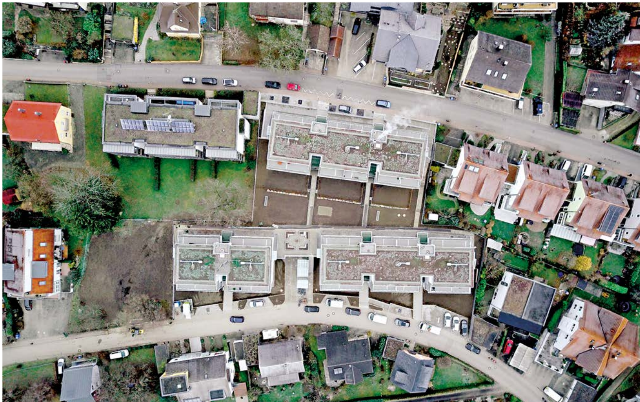
Die drei Neubauten in Radolfzell aus der Vogelperspektive – eines von vielen Bauprojekten der Genossenschaft, die alle neu entstehenden Wohnungen mit Glasfaser und SAT-TV ausstatten will
