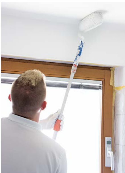
Die Kombination aus Klimagriff und einer Spezialfarbe mit hygrothermischen Eigenschaften reduziert die Gefahr der Schimmelbildung
