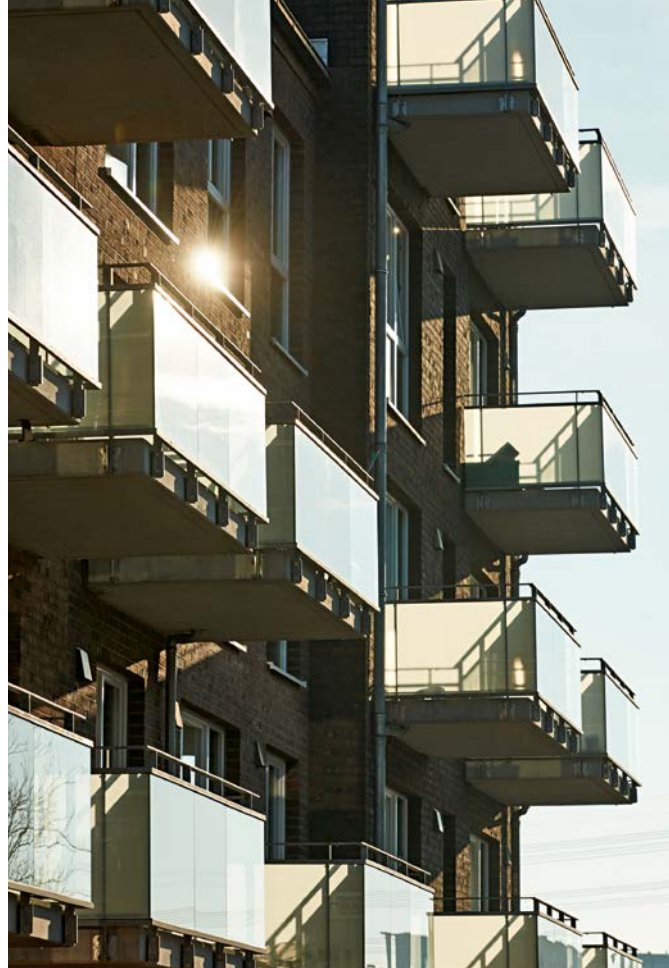
Alle Wohnungen sind mit Balkonen oder Terrassen ausgestattet
