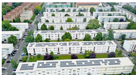
Die Frankfurter Friedrich-Ebert-Siedlung der ABG, die als eine der Pioniere für smartes und energieeffizientes Bauen in Deutschland gilt
