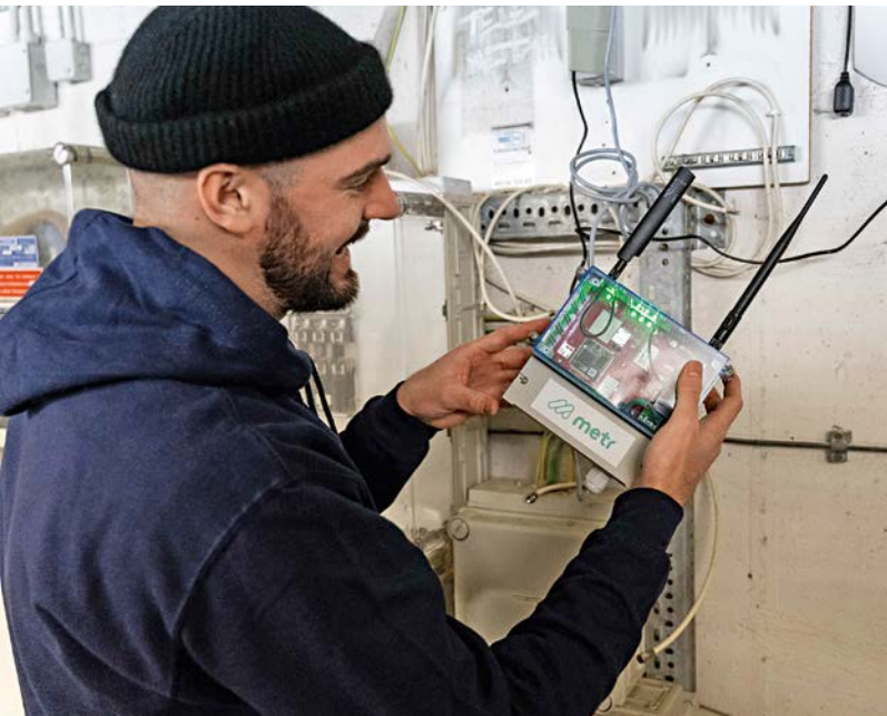
Ein Metr-Mitarbeiter bei der Installation des M-Gates
