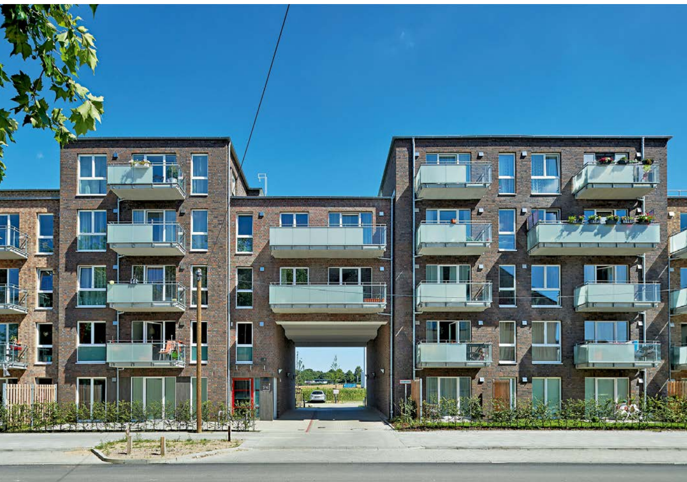
Die Klinkerfassade des inklusiven Wohnhauses ist klassischen Stadthäusern nachempfunden
