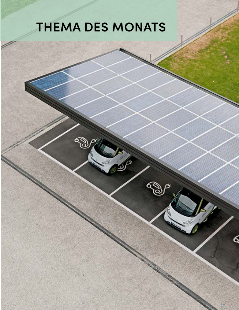
Photovoltaikanlagen an Wohngebäuden und die Nutzung des erzeugten Stroms für die Ladung von E-Autos haben einige Hürden zu überwinden
