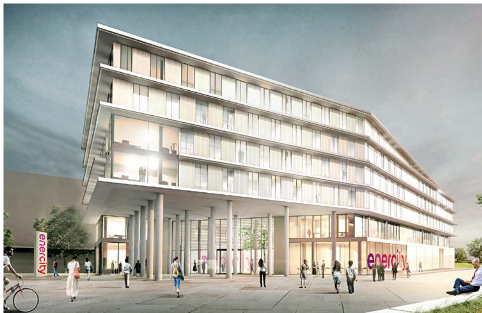
Die neue Enercity-Zentrale entsteht auf einem Grundstück des Energiedienstleisters
