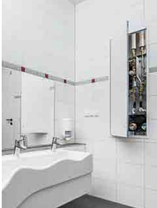
station integrierten Plattenwärmetauscher exakt auf Zapftemperatur erwärmt. Der abgekühlte Heizungsvorlauf fließt wieder zurück zur Heizzentrale. Die Kreisläufe für Heizwasser und Trinkwasser sind in sich geschlossen.
