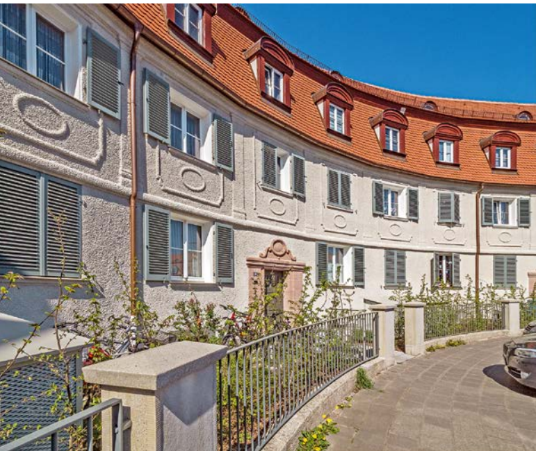
Die Fassaden am Volckamerplatz machen den Gestaltungsanspruch und Vorzeigecharakter der Siedlung deutlich
