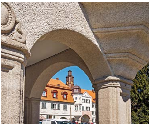
Die aufwendigen Details der ersten Bauabschnitte wurden akribisch gesichert und wiederhergestellt. Die Putze erhielten mit einer händisch bedienten sogenannten Putzorgel ihre bauzeitliche Fassung
