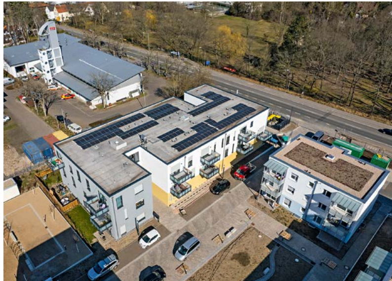
Auf einem ehemaligen Gewerbegelande in Dreieich wurden vier Baufelder für die innerstädtische Nachverdichtung erschlossen. Zwei dreigeschossige Häuser mit insgesamt 37 barrierefreien, teilweise rollstuhlgerechten Ein- bis Fünfstückerwohnungen errichtete die kommunale Dreieichbau
