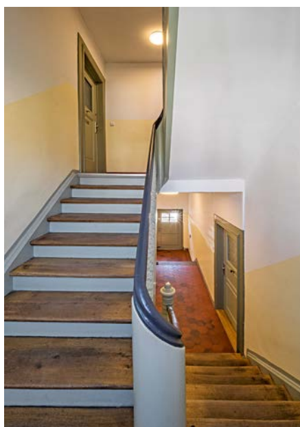
Die Treppenhäuser erhielten anhand der Befunduntersuchungen des Restaurators ihre ursprünglichen, individuellen Farbfassungen zurück
