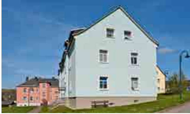
Gebäude in Raschau-Markersbach vor (L.) und nach der Beschichtung
