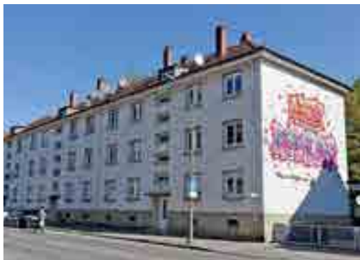
Für ein paar Tage wurden die Gebäude in der Romeiasstraße zum kulturellen Zentrum der Stadt Singen
