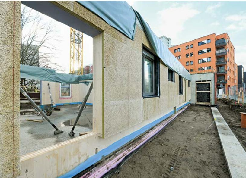
Putzgrundvorbereitung: Die tragenden Außenwände in Holzbauweise sind für den mineralischen Außenputz vorbereitet und bis zum Putzauftrag vor direkter Bewitterung durch eine Abdeckung oberseitig geschützt
