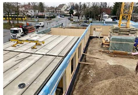
Eine Symbiose aus Holz und Beton: Die Platten der Betondecken werden auf der vorbereiteten Holzkonstruktion verlegt
