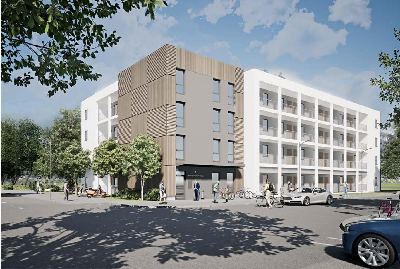
Klimafreundlicher Neubau: Die Degewo errichtet in der Gropiusstadt bis Herbst 2022 zwei vier- bis sechsgeschossige Holzhybridbauten mit insgesamt 88 Mietwohnungen. Die Fassaden in Holzbauweise werden zum Teil mit einem mineralischen Putz und im Bereich der Treppenhäuser mit einer differenziert gestalteten, massiven Holzschalung ausgeführt
