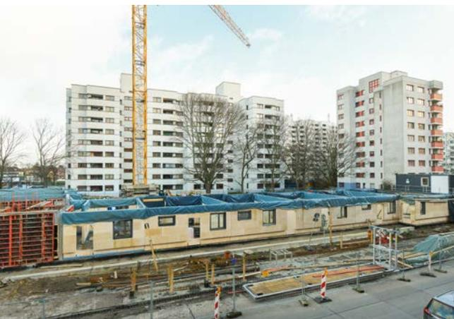
Mischbauweise: Tragende Innen- und Außenwände werden als vorgefertigte Massivholz-Elemente ausgeführt, während das Treppenhaus aus Beton entsteht
