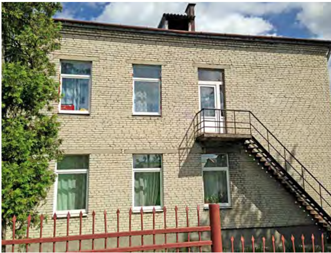
Der Kindergarten in Zhovkva vor der Sanierung ...
