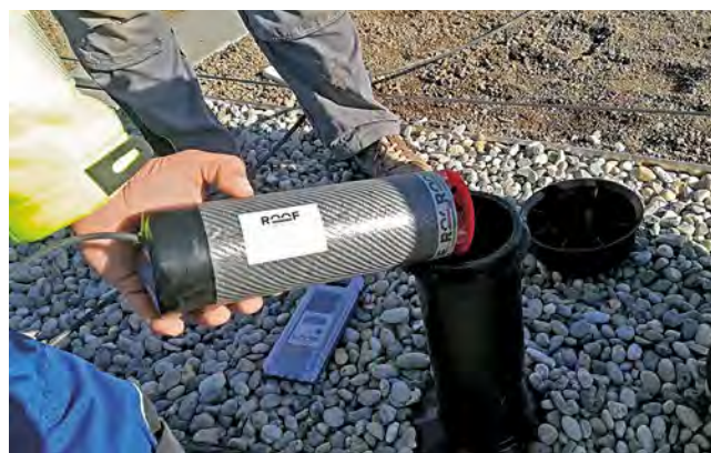
Der Einbau des Messgerätes kann in jedes Flachdach erfolgen
