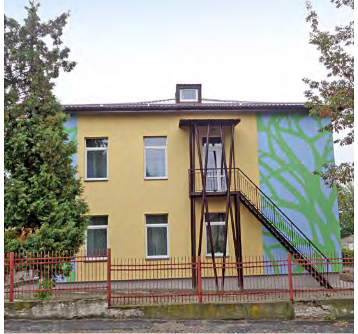
... und der Kindergarten in Zhovkva nach der Sanierung
