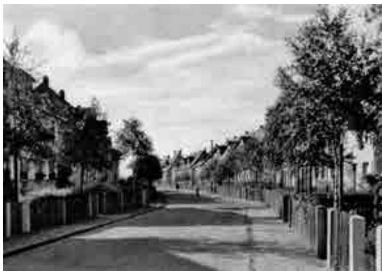
Straßenansicht Resedenweg von 1932
