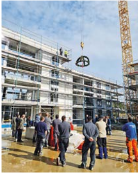
Ein Meilenstein ist geschafft: Richtfest war Mitte Oktober
