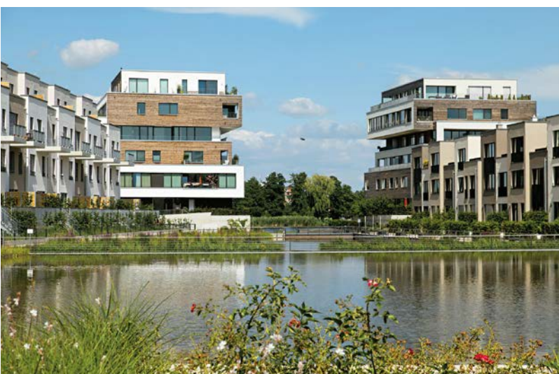
Das 6.000 m 2 große Wasserbecken ist das zentrale Element des Schwammstadt-Konzepts
