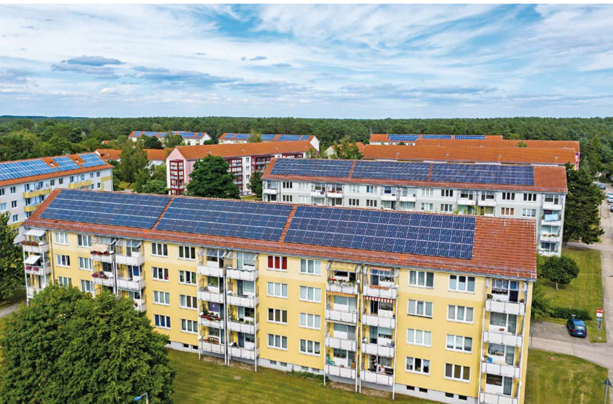
Alle Wohnhäuser mit mindestens vier Geschossen werden mit Photovoltaikanlagen ausgestattet
