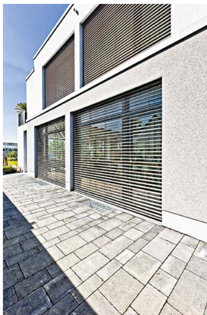
Der Raffstorekasten lässt sich laut Hersteller schnell und einfach in die Dämmebene integrieren und problemlos überputzen
