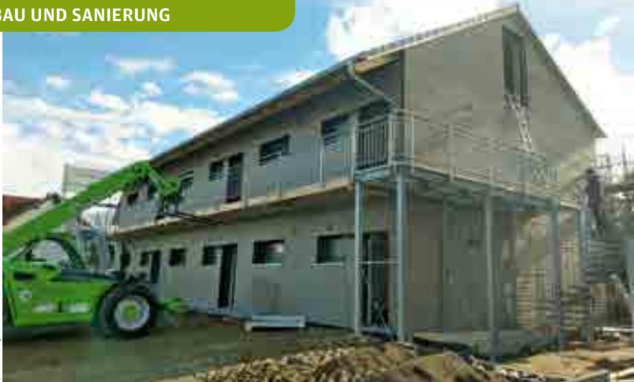
Die Außenwände der Module bestehen u. a. aus einer Massivholzwand und einer Holzfaserdämmplatte. Die Holzoberfläche ist im Typ Fichte Doppelrhombus mit einer Vorvergrauungsglasur ausgeführt
