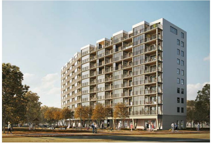
Das Wohnhochhaus Sterntalerweg 1+3 von 1968 wird saniert und um ein Geschoss aufgestockt. Die 72 Wohnungen erhalten halbverglaste Balkone
