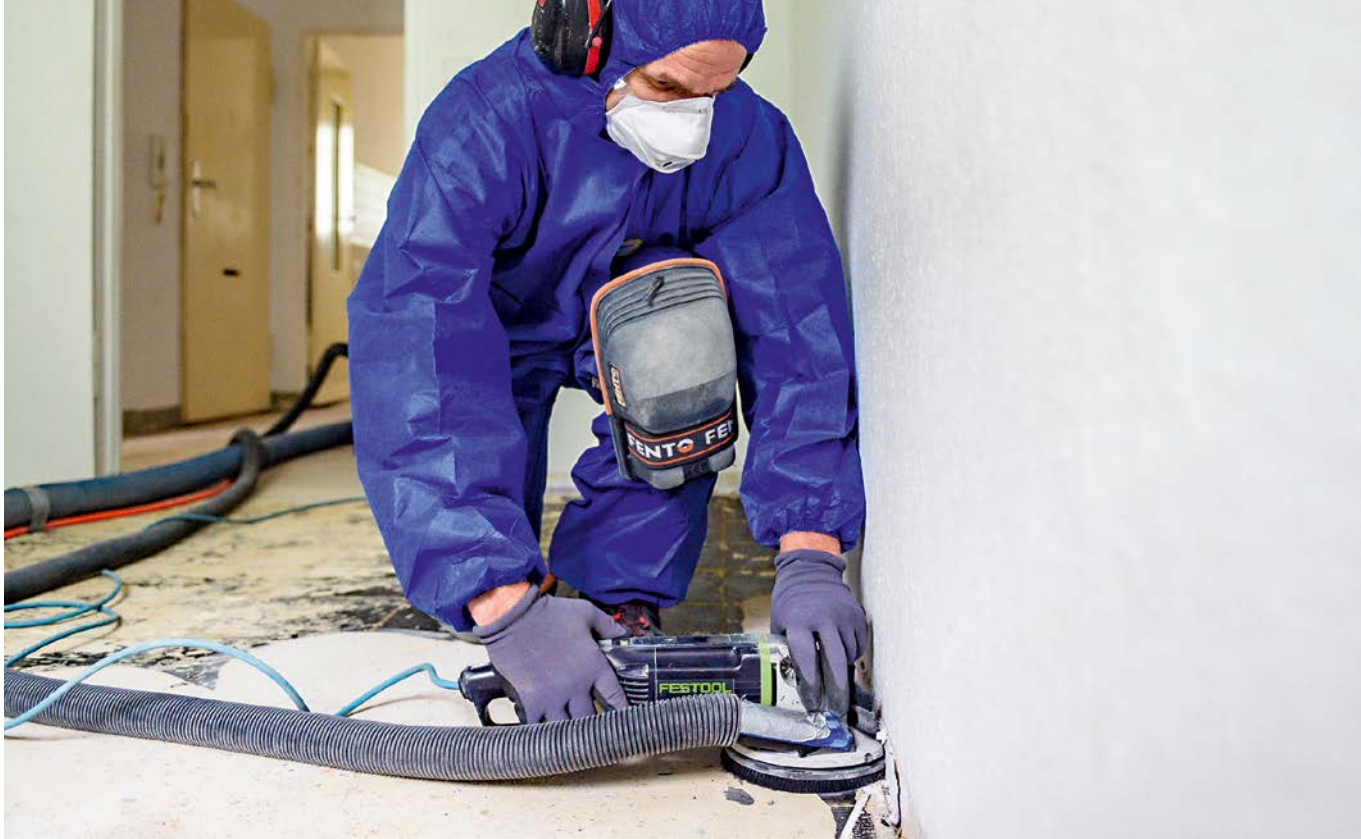
Zentrales Element des emissionsarmen Degewo-2-Verfahrens ist der abgetrennte Schwarzbereich, in dem die Asbestsanierungsarbeiten durchgeführt werden
