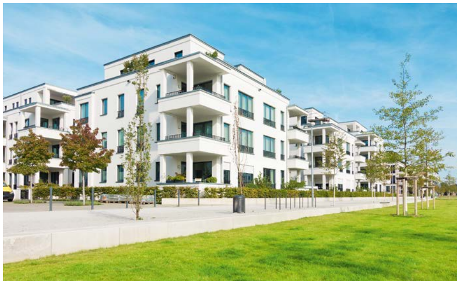
Verwalter, die Immobilien nach den Vorgaben des Wohnungseigentumsgesetzes (WEG) betreuen wollen, müssen erst ab Dezember 2023 eine Zertifizierung nachweisen
