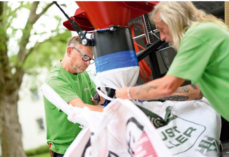
Zertifiziert als Sanierungsfachbetrieb: die DTD hat ein eigenes emissionsarmes Verfahren zur schnellen und qualitativ hochwertigen Beseitigung von asbesthaltigen Materialien entwickelt
