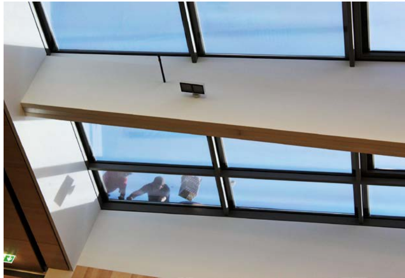
Bei einem Brand entstehen gefährliche Rauchgase, die bei fortschreitender Branddauer zu einer Selbstzündung führen können. Automatisierte Dachfensteröffnungen dienen der mechanischen Entrauchung
