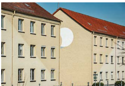
Insgesamt 30 Objekte hat die Wohnungsgenossenschaft Perleberg eG mit ThermoProtect beschichtet
