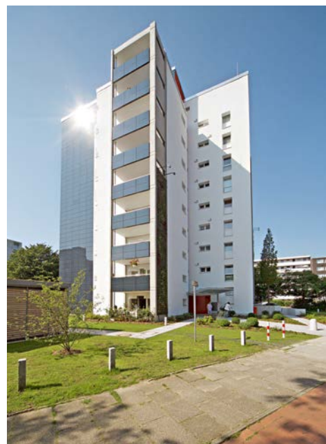
Durch sichtbare Projekte gewinnen die Quartiere an Attraktivität: energetisch saniertes Punkthaus der Bremer Gewoba in der Gartenstadt Vahr
