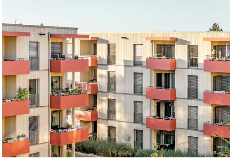
Bereits 1999 hat die FSB Wohngebäude aus Holz errichtet. Damals stellten der Brand- und Schallschutz noch große Herausforderungen dar. Inzwischen können im Holzbau bessere konstruktive Lösungen realisiert werden
