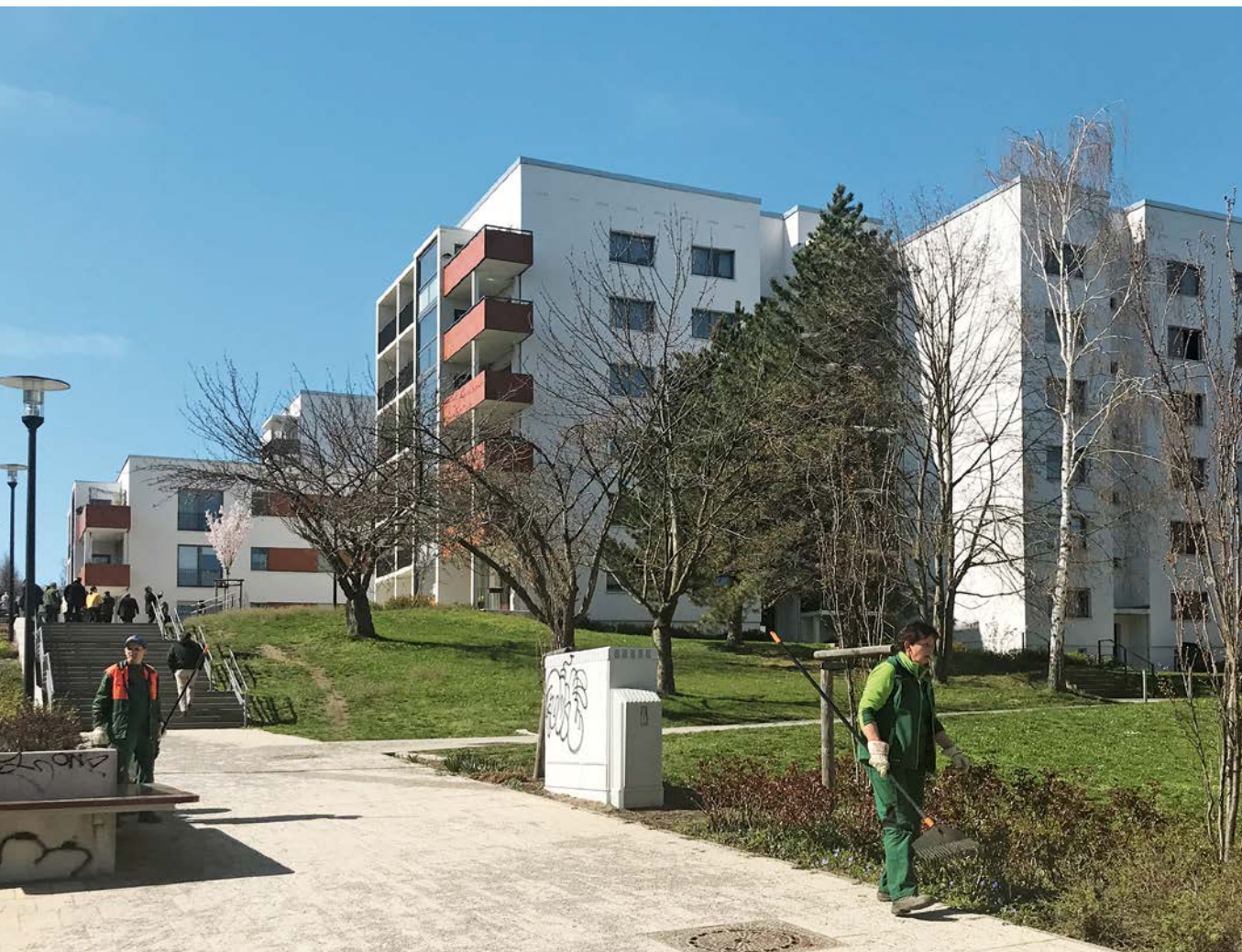
Die Eisenbahner-Wohnungsbaugenossenschaft Dresden eG hat mit der ‚Höhenpromenade‘ den zentralen Teil der Großsiedlung Dresden-Gorbitz erneuert. In den Punkthäusern entstanden barrierearme Seniorenwohnungen
