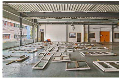
Die Wiederverwendung von Materialien – hier Fenster – wird in den nächsten Jahrzehnten zur Selbstverständlichkeit werden
