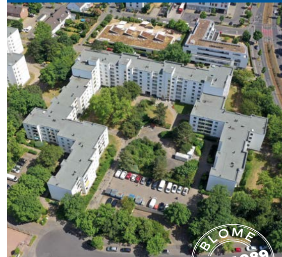
Bonn: Sanierungsprojekt mit 300 Wohneinheiten
