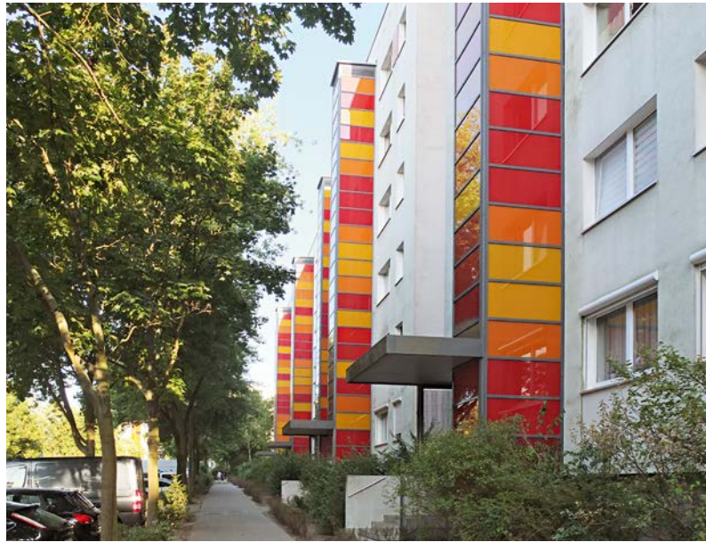
Bestandserneuerung in Berlin-Hellersdorf (Rotes Viertel): Bei der Sanierung wurden die Eingangsbereiche und Erdgeschosszonen um- sowie Fahrstühle angebaut
