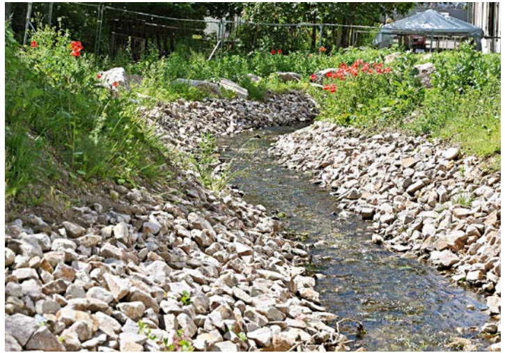
Das bislang unterirdisch verlaufende Runzgewässer wurde in die Quartiersmitte verlegt und verläuft künftig offen durch das Quartier
