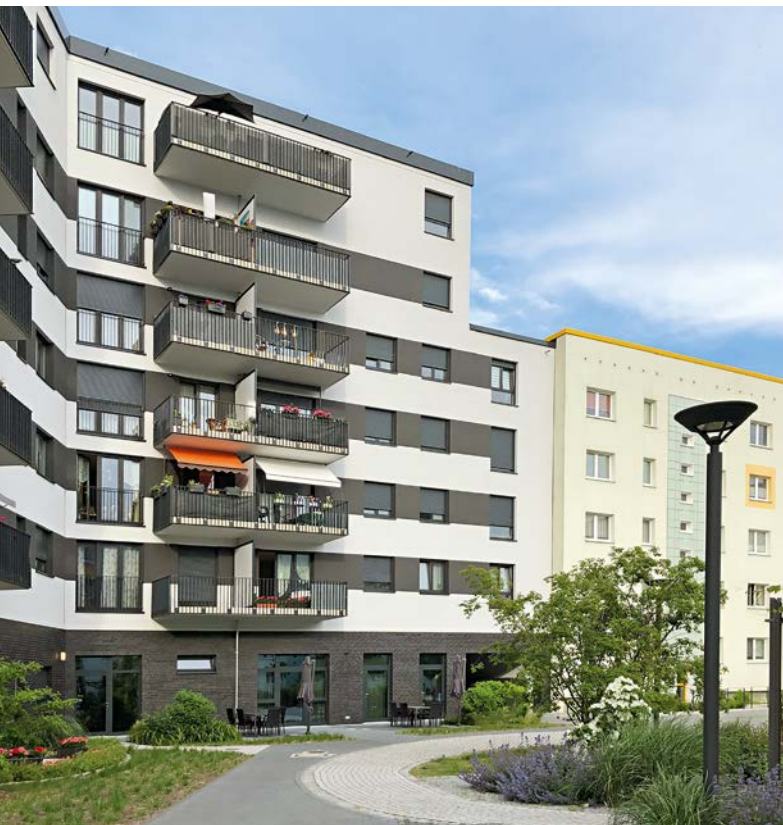
Anbau der Wildauer Wohnungsbaugesellschaft mbH an Bestandsgebäude in der Großsiedlung Wildau-Hoherlehme
