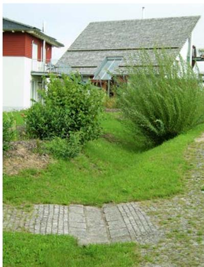
Diese bewachsene Mulde verläuft in Form eines durchgehenden Grabens mit leichtem Gefälle und sammelt das Regenwasser der Gebäude und Grundstücke ein
