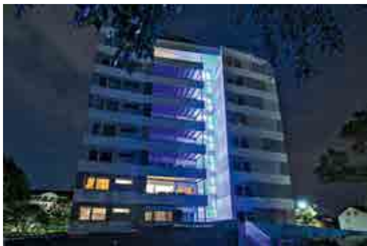
Nicht nur ein barrierefreier Zugang zu den Punkthäusern wurde geschaffen – ein Lichtkonzept weist den Bauten nun unterschiedliche Farben zu
