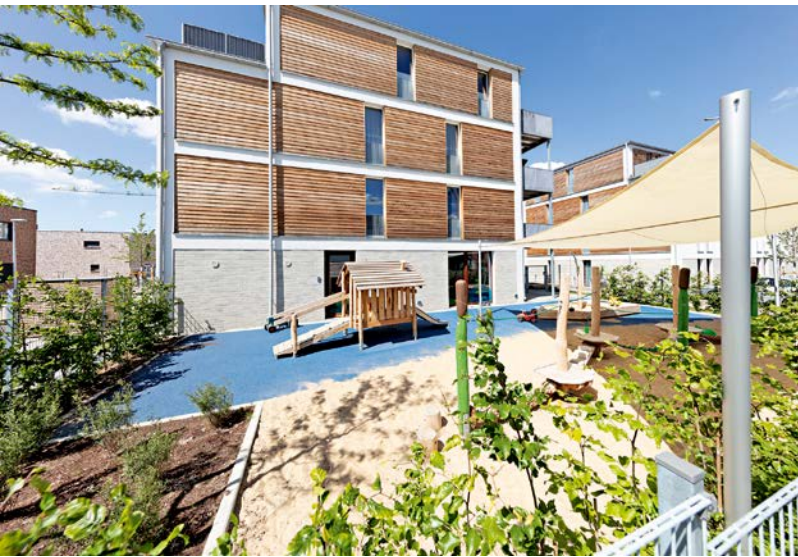
Im Erdgeschoss eines der Neubauhäuser befindet sich eine Kita mit Gartenbereich, um vor allem Familien ein attraktives Wohnumfeld zu bieten
