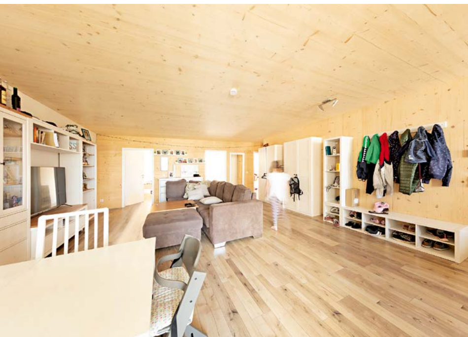
Die Brettsperrholzelemente der Neubauten wurden an Decken und Wänden in Sichtqualität montiert, sodass die Raumboflächen mit Montage fertiggestellt und dadurch Baukosten gesenkt werden konnten
