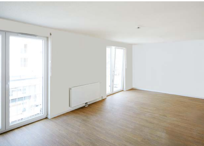
Die groß dimensionierten Planken im Format 18,4 × 121,9 cm wurden von den Verlegern der Fußbodenzentrale Frankfurt im Dryback-Verfahren vollflächig verklebt
