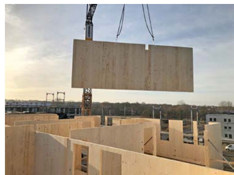
... werkseitig vorgefertigte BSP-Elemente mit Oberflächen in Sichtqualität in Kurzzeit platziert
