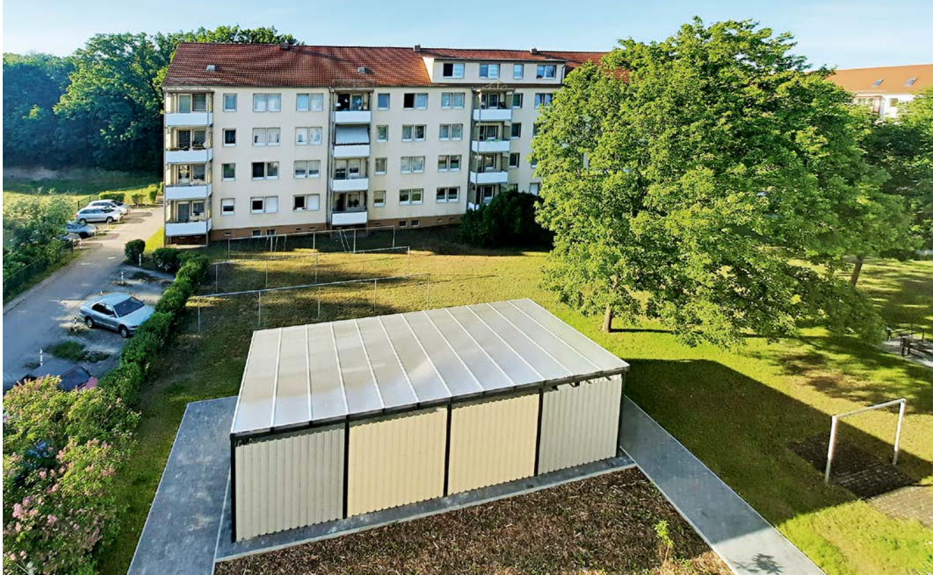
Für das Projekt ausgesucht wurden ganz normale Wohnhäuser aus der Nachkriegszeit. In diesem Wohnblock der GWG Lübben wurde die smarte Technik erfolgreich getestet
