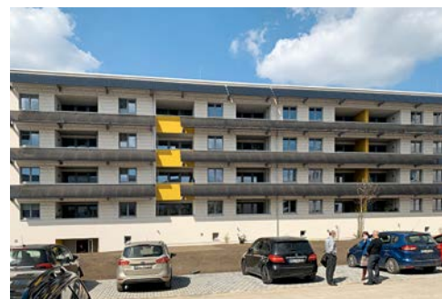
Die Photovoltaikmodule an der Fassade sorgen für ein ungewöhnliches Erscheinungsbild des Mehrfamilienhauses in Meißen-Nassau
