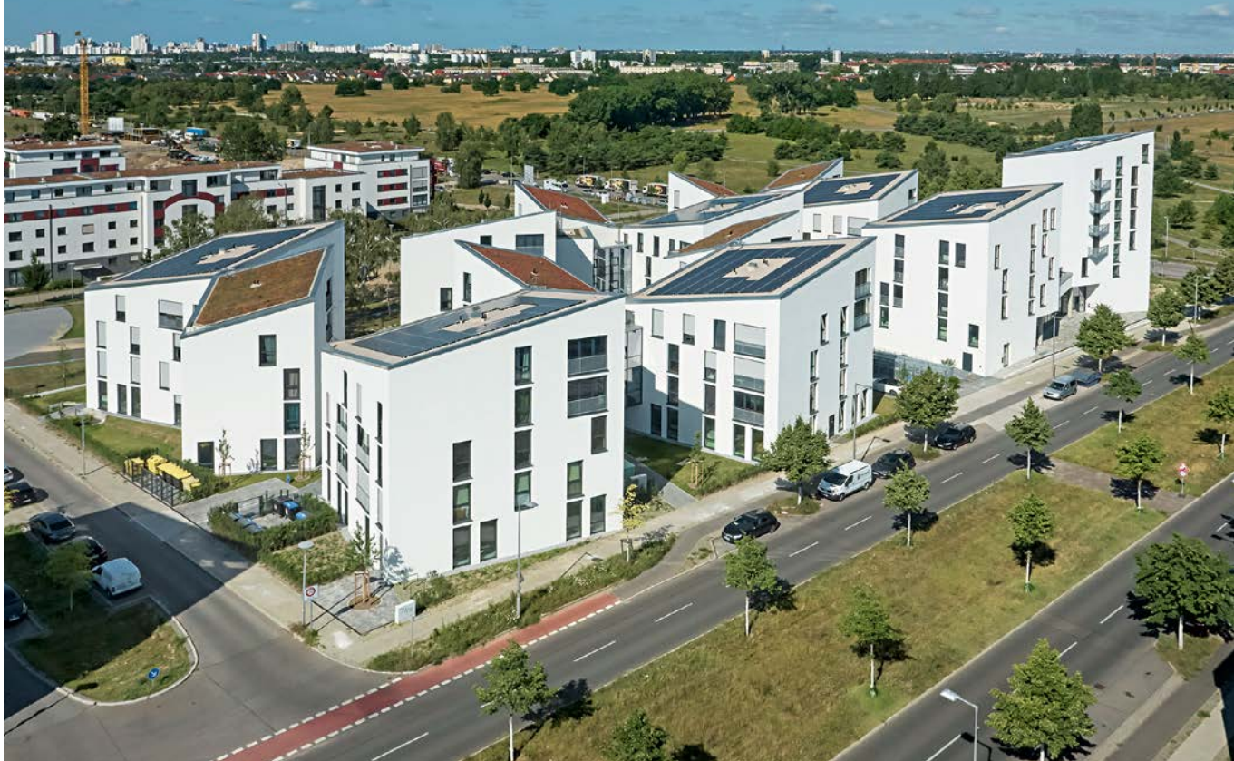
Luftbildaufnahme des im Jahr 2020 fertiggestellten Projekts Future Living Berlin: Auf den Dächern gut erkennbar sind die Photovoltaikmodule zur Erzeugung des Mieterstroms
