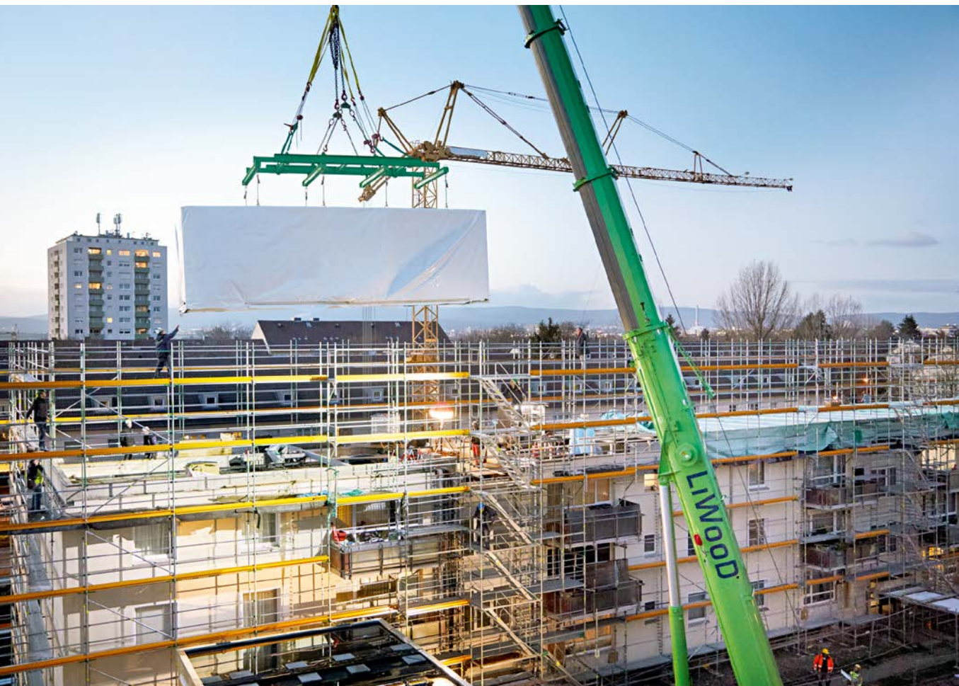
In der Platensiedlung in Frankfurt wurden 19 bis dato dreigeschossige Zeilenbauten durch eine modular aufgebaute Holzkonstruktion auf fünf Geschosse aufgestockt
