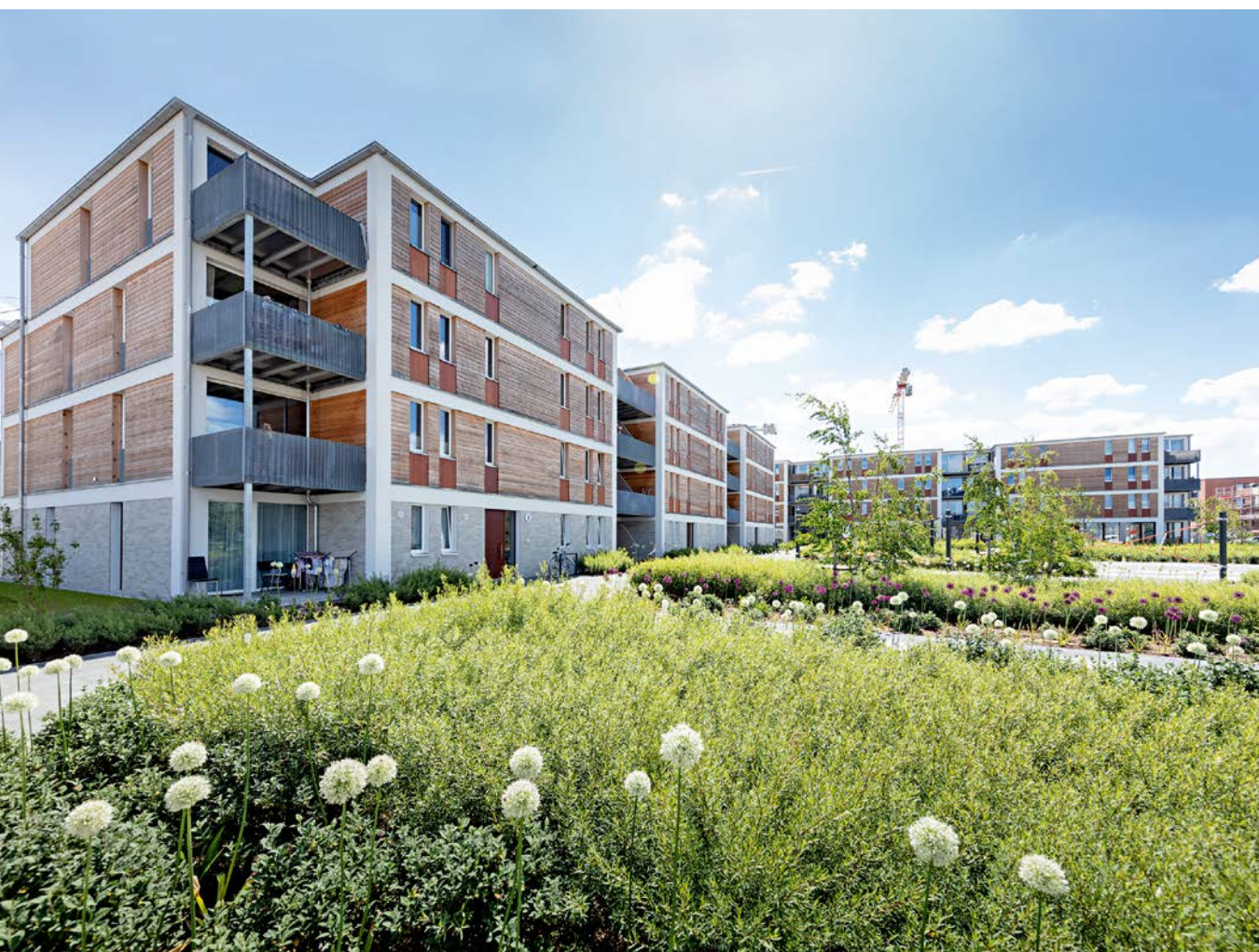
Im Baugebiet „Vogelkamp“ im Hamburger Stadtteil Neugraben-Fischbek umrahmen viergeschossige Holzbauten einen begrünten Quartiersvorplatz
