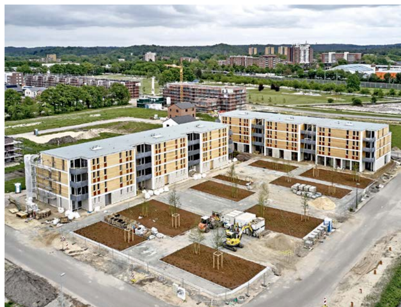
Das naturnahe Bauen und Wohnen mit dem Baustoff Holz steht im Vordergrund der Quartiersentwicklung in Neugraben-Fischbek. Das Modellprojekt „8 €-Wohnungsbau“ entstammt der IBA Hamburg
