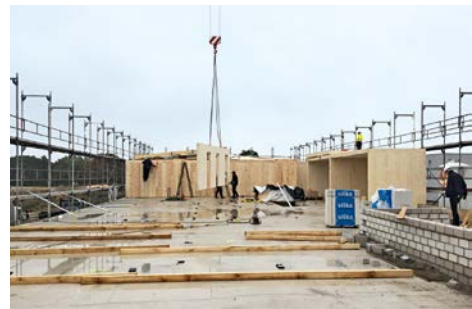
Um die mit Kalksandstein gemauerten Erschließungskerne, die die Treppenhäuser beherbergen, wurden ...
