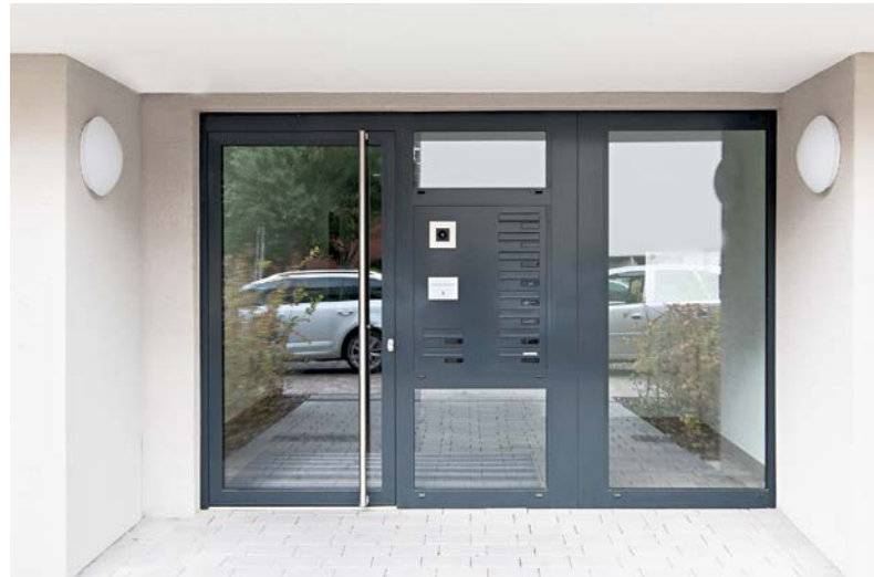
Eine zukunftsfähige technische Gebäudeinfrastruktur basiert unter anderem darauf, dass Hersteller Schnittstellen schaffen
