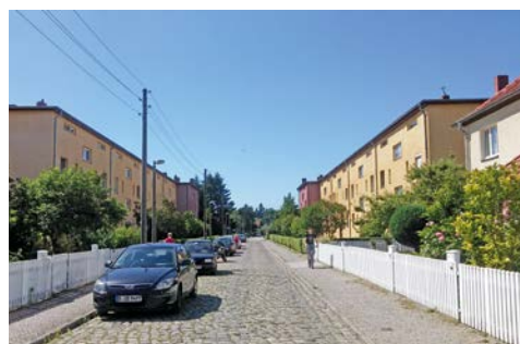
In diesen Blocks der ABG Paradies wurden Raumsensoren und smarte Ventilregler eingesetzt
