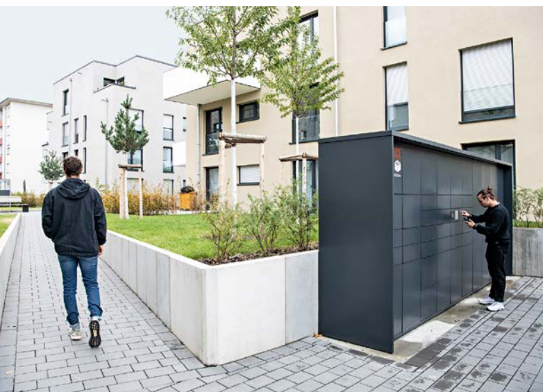
Die Paketbox-Anlage ist über eigens entwickelte offene Schnittstellen mit der Türkommunikation verknüpft. Per App können Mieter auf beide Funktionen zugreifen
