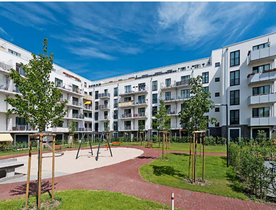
Im Winter 2016 wurde auf dem Dach des Quartiers Gärtnerhof in Berlin-Lichtenberg die erste Mieterstromanlage der Howoge installiert. Mehr als 80% der Mieter haben einen Stromvertrag abgeschlossen
