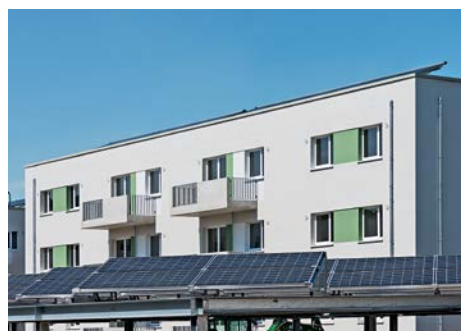
Als Plusenergiehaus erzeugt das Powerhaus in Berlin-Adlershof mehr Energie, als vor Ort verbraucht wird. Die hocheffiziente Gebäudehülle, die Lüftungsanlage mit Wärmerückgewinnung, thermische Solarkollektoren sowie PV-Module ermöglichen warme Betriebskosten von monatlich 0,30 €/m 2
