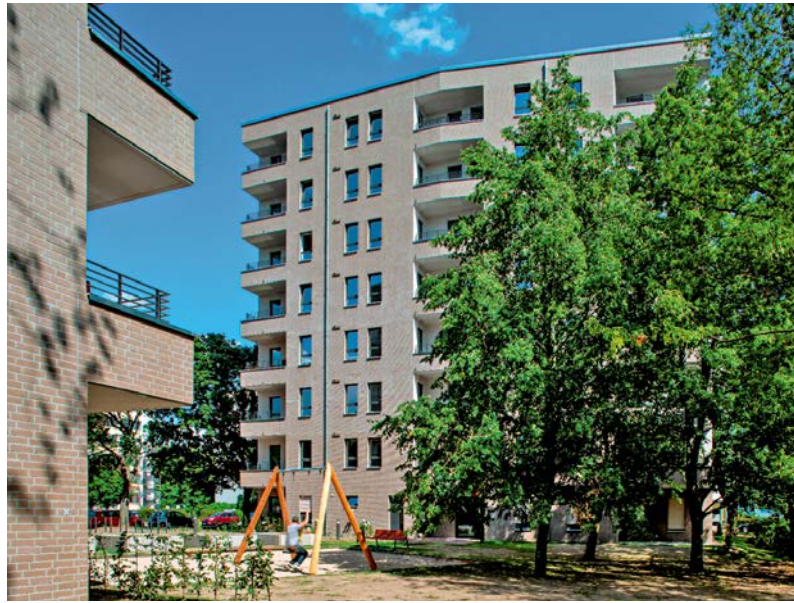
Im Pilotprojekt in der Sewanstraße wurde erstmalig ein elektrischer Quartierspeicher verbaut. Damit sind die Gebäude zu rund 70 % energieautark
