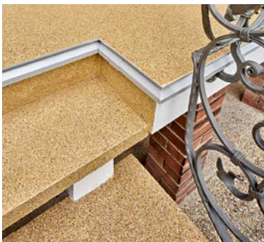
Schutz vor Schäden und eine Trittschall-Reduzierung vereint ein neues Beschichtungssystem für Balkone
