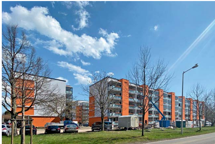
Gehwege, Sitz- und Aufenthaltsmöglichkeiten sowie ein kleiner „Enkelspielplatz“ werden in den kommenden Wochen rund um die Seniorenwohnanlage entstehen
