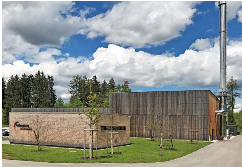
Oberirdischer Teil der Geothermieanlage in Grünwald
