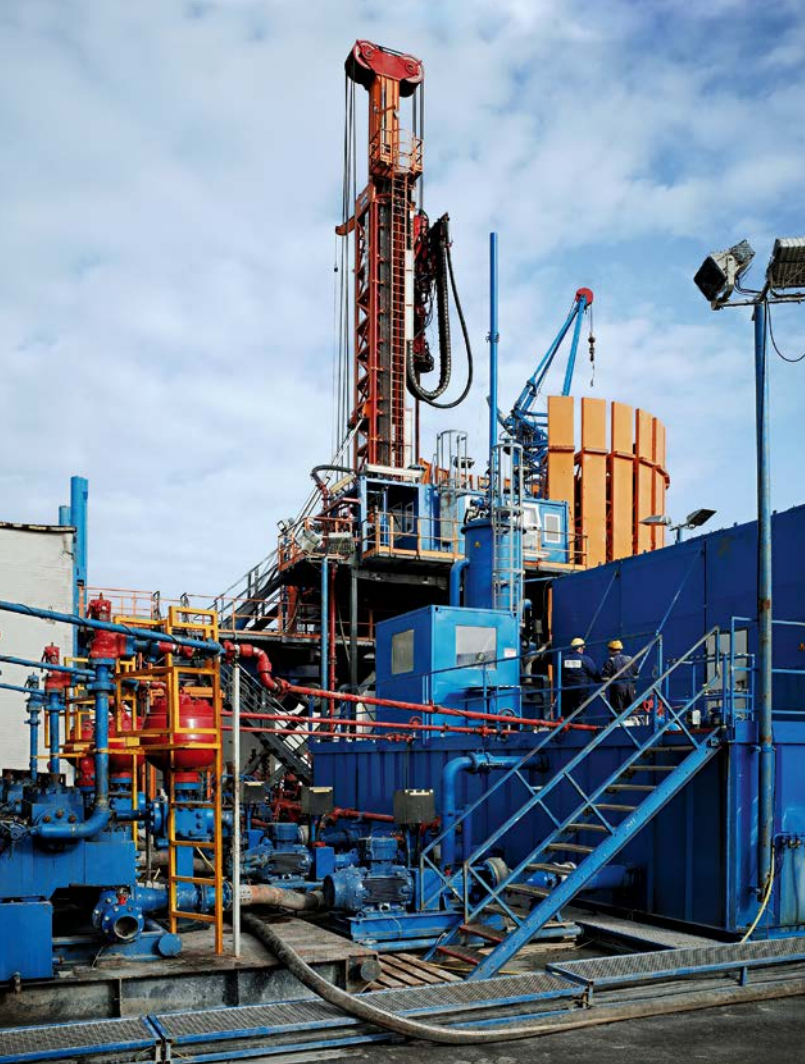
Bohranlage in Schwerin
