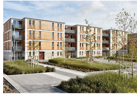
Im Vogelkamp im Hamburger Stadtteil Neugraben-Fischbek sind im Rahmen der IBA Hamburg 8-€-Wohnungen entstanden
