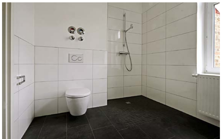
Barrierefreiheit war bei der Modernisierung ein wichtiger Punkt – ließ sich wegen der historischen Bedeutung des Gebäudes aber nicht überall umsetzen
