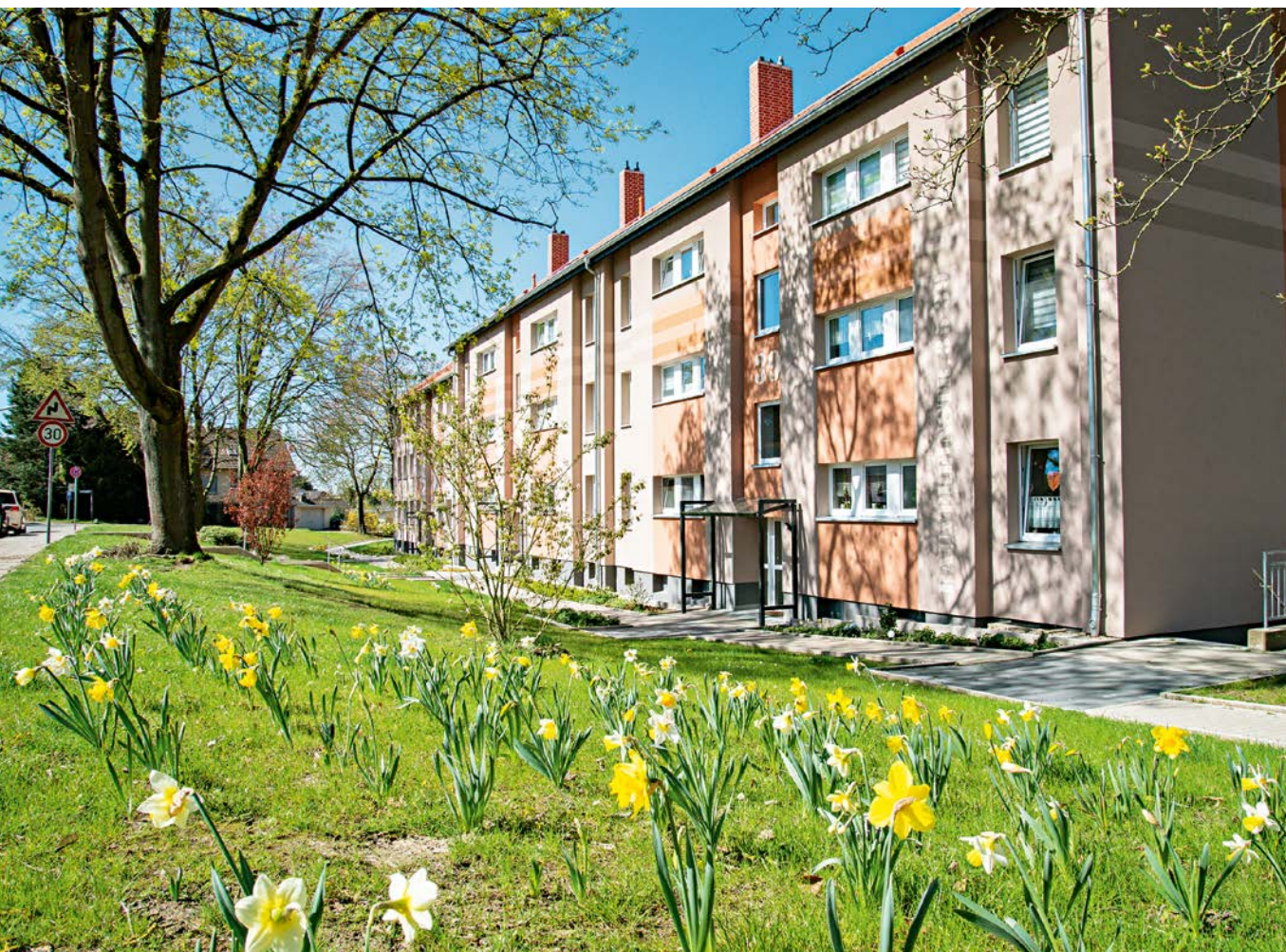
In der Bauvereinstraße 37-39 erfolgte 2020 die Modernisierung samt Wärmedämmung, Dach- und Fenstererneuerung
