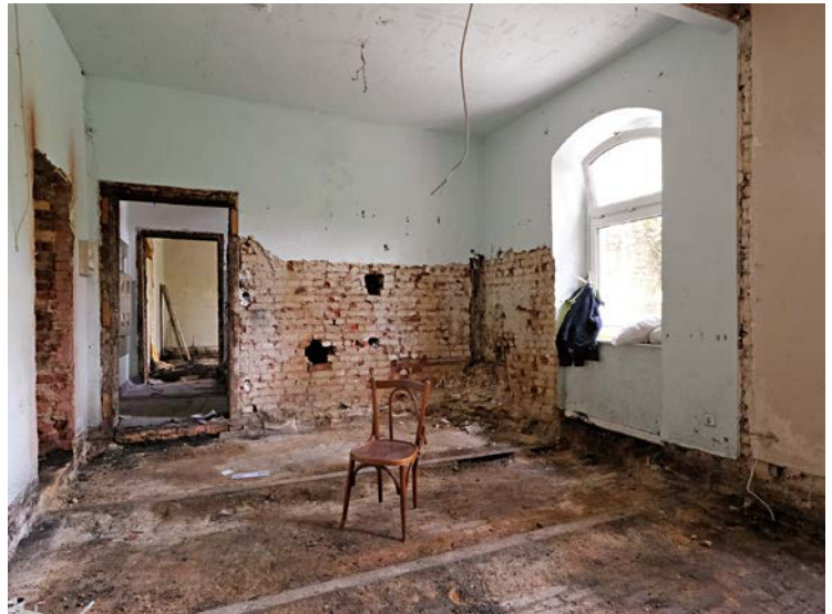
Komplett entkernt lässt sich am Boden des Erdgeschosses gut die Kappendecke des Kellers erkennen
