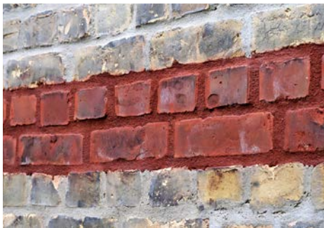
Die Verfugung der Fassade musste aufwendig in Handarbeit restauriert werden. Der Aufwand hat sich für die SWD aber gelohnt
