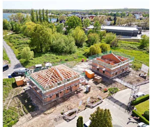
Am ehemaligen Bitterfelder Stadtbad hat die Neubi zwei Gebäude mit je 120 m 2 Wohnfläche in Massivbauweise errichtet
