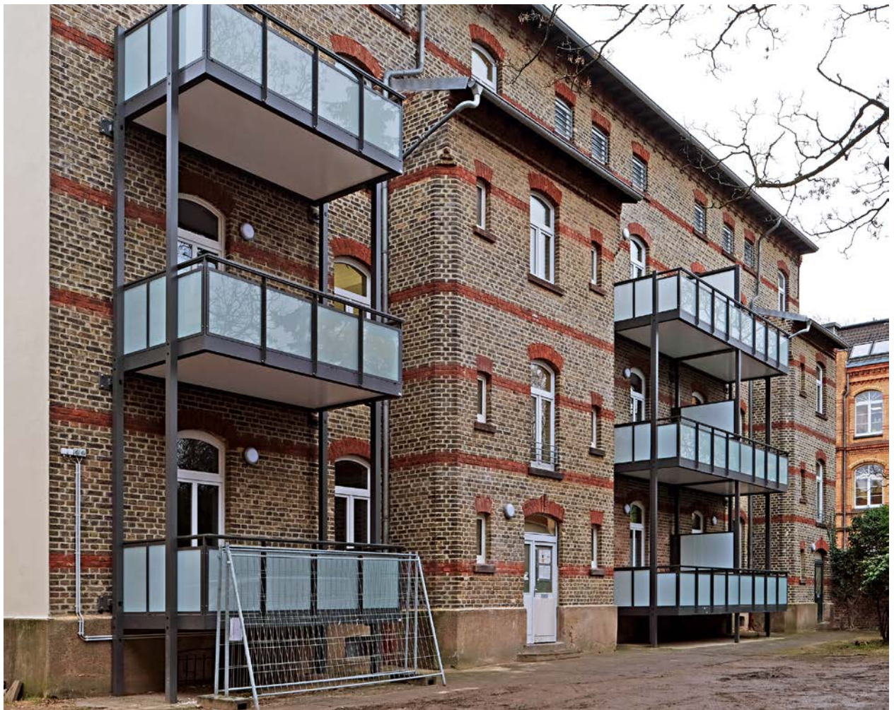
Moderne Anbaubalkone erhöhen den Wohnkomfort für die Mieterinnen und Mieter in dem von Grün umgebenen Hinterhofgebäude ohne Straßenverkehr
