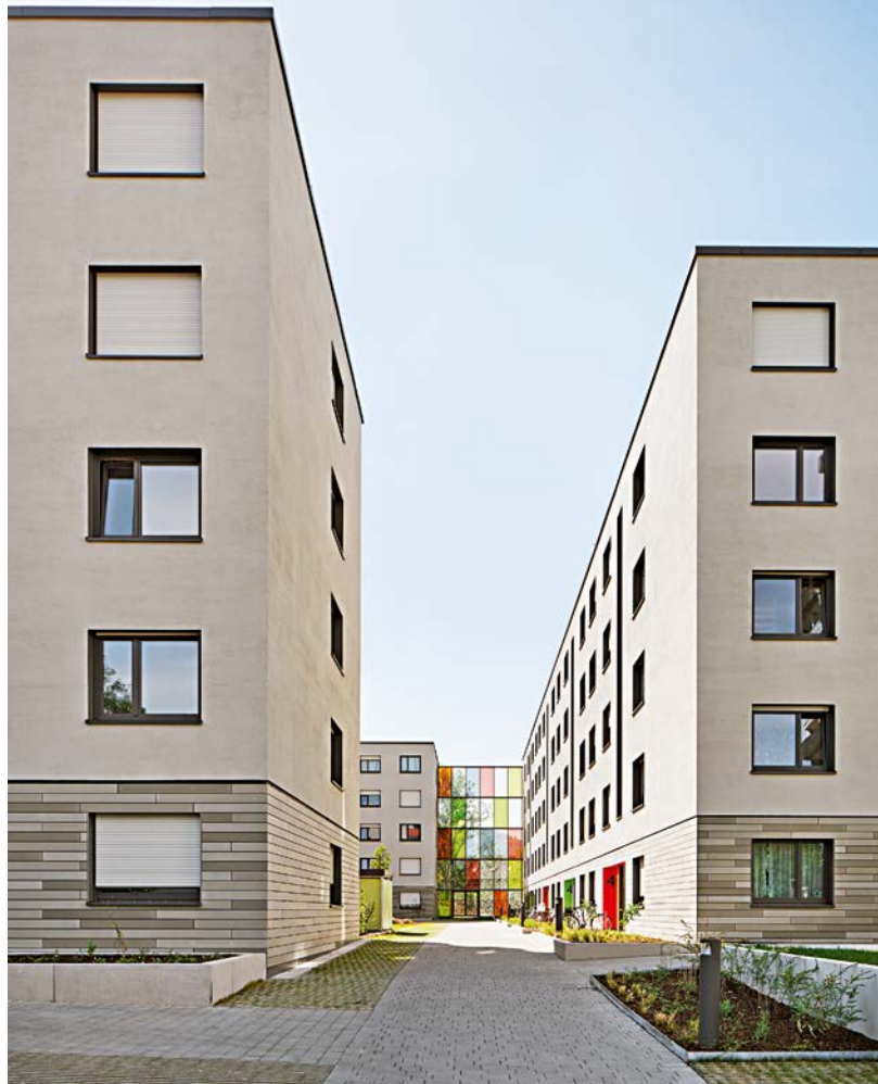
Eine gebäudehohe, gläserne Schallschutzwand schirmt den Innenhof wirksam gegen den Lärm der Umgebung ab. Das Farbkonzept setzt sich hier fort
