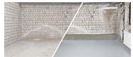
Ein Kellerraum im Vorzustand (links) und der gleiche Raum nach der Abdichtung des Wand- und Sohlenanschlusses und des Bodens
