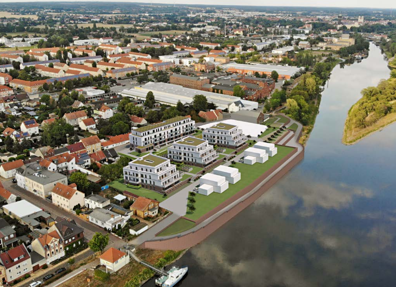
Wohnen am alten Stadthafen: nicht weit von der historischen Altstadt entfernt realisiert die Wiwog ein vielfältiges Projekt, mit dem sie hochwertige Angebote schafft und die Stadt als Wohnstandort neu positionieren möchte
