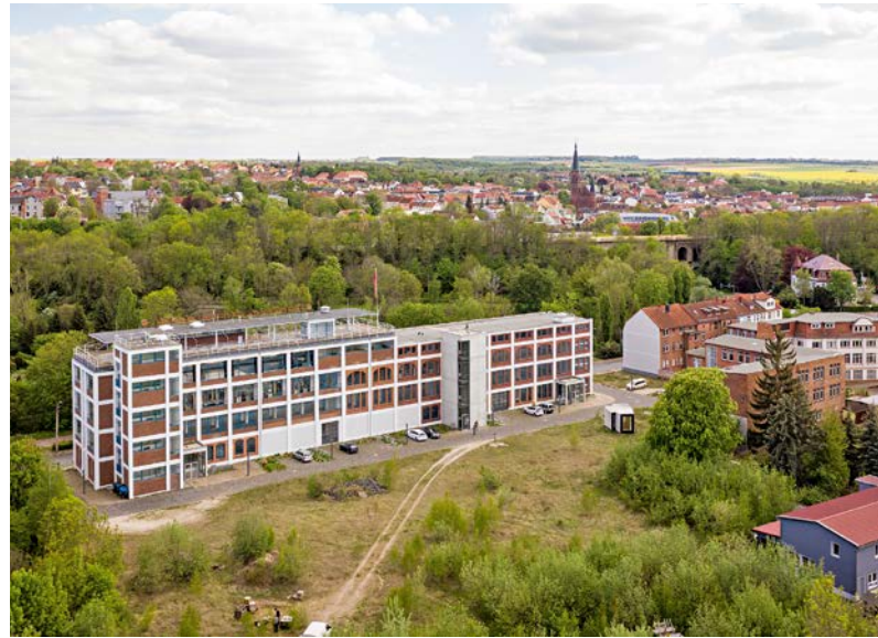
Der denkmalgeschützte Eiermannbau in Apolda wurde nach dem Motto „Wie wenig ist genug“ nach jahrelangem Leerstand zu einer „Open Factory“ entwickelt. Ein Möglichkeitsraum entstand
