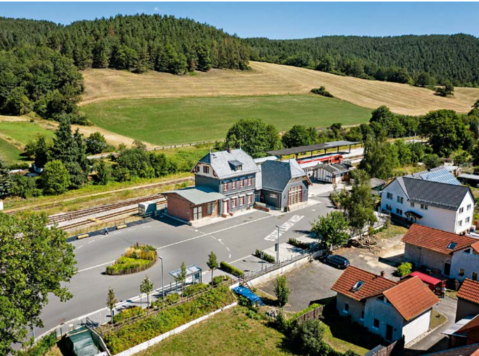
Der Bahnhof Rottenbach wurde vor dem Verfall gerettet und zu einem vielseitigen Ort umgebaut, der heute als „Bahn-Hofladen“ der Nahversorgung, dem sozialen Austausch und der Nahverkehrsanbindung dient
