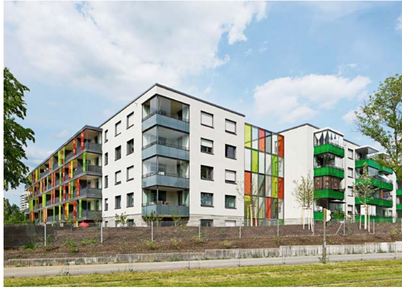
Verglasungen für Balkone und Loggien zur lärmbelasteten Seite optimieren die Akustik deutlich
