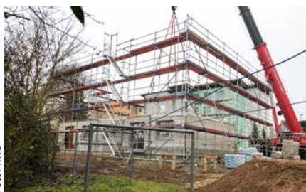
...nach dem „Lego-Prinzip“ aufeinander gestapelt.
