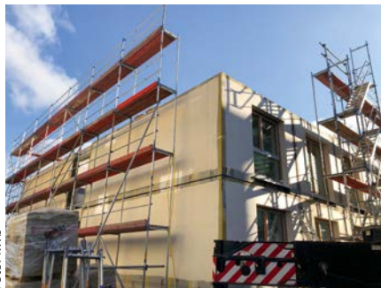
Die serielle und modulare Bauweise ist schnell und kostengünstig – und schont durch die kurze Baustellenzeit von acht Wochen auch die Nerven der direkten Anwohner. Nach Fertigstellung ist dem Gebäude die Modulbauweise nicht anzusehen.
