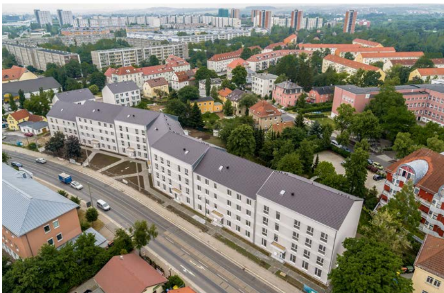
Die modular und seriell gefertigten Mehrfamilienhäuser haben unterschiedliche Trauf- und Sockelhöhen – so wirken sie wie Einzelhäuser.
