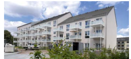
Jede der Drei- und Vierraumwohnungen verfügt über einen Balkon beziehungsweise im Erdgeschoss über eine Terrasse mit Mietergarten.
