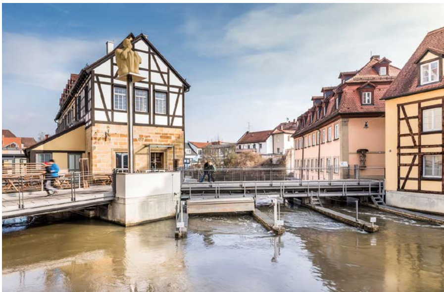
Das Projekt der Joseph-Stiftung in Bamberg ist eines von fünf nominierten wohnungswirtschaftlichen Projekten aus Deutschland. Ein Unterwasserkraftwerk in der Regnitz versorgt dort die Nachbarschaft mit erneuerbarer Energie.
