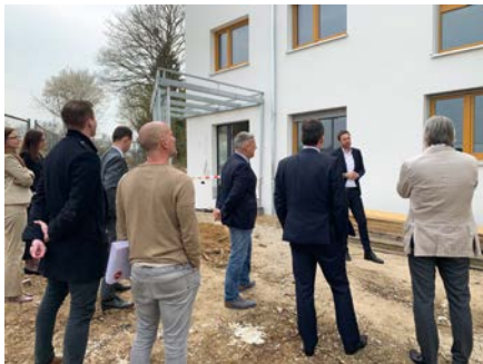
Für das Bauprojekt wurden Stahlbeton-Raum-Module in Massivbauweise und mit hohem Vorfertigungsgrad verwendet – nach Fertigstellung ist dem Gebäude die Modulbauweise nicht anzusehen.
