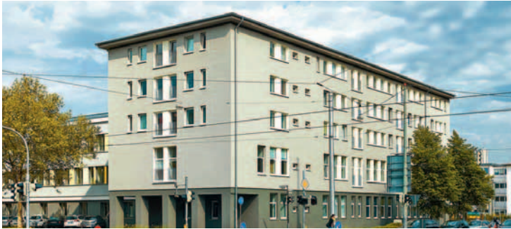
Foto: Bauverein AG Darmstadt
