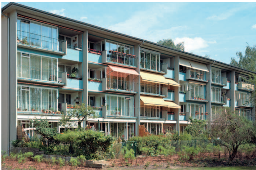
Die Berliner Bau- und Wohnungsgenossenschaft von 1892 wurde für die energetische Sanierung eines Wohnensembles mit dem Sonderpreis „Denkmalschutz im Wohnungsbau“ ausgezeichnet.
