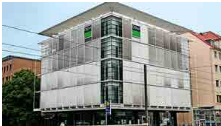
Hauptgebäude. Zentrale Außenansicht der Gisma in Hannover.
