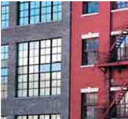
Gewerbeimmobilie will saniert werden.
