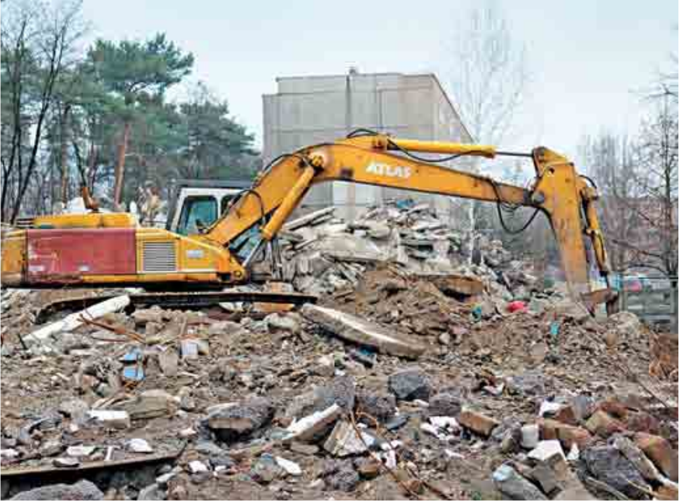
Weil die Bevölkerung wegzieht, bleibt für viele Immobilien in Ostdeutschland nur der Abrissbagger.
