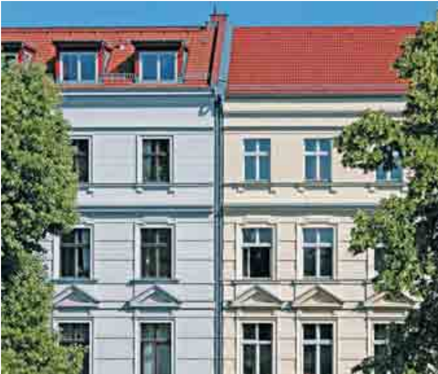
Die Fördermittel für die energetische Modernisierung sollen gekürzt werden.
