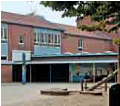
Strabag übernimmt Schulsanierung
