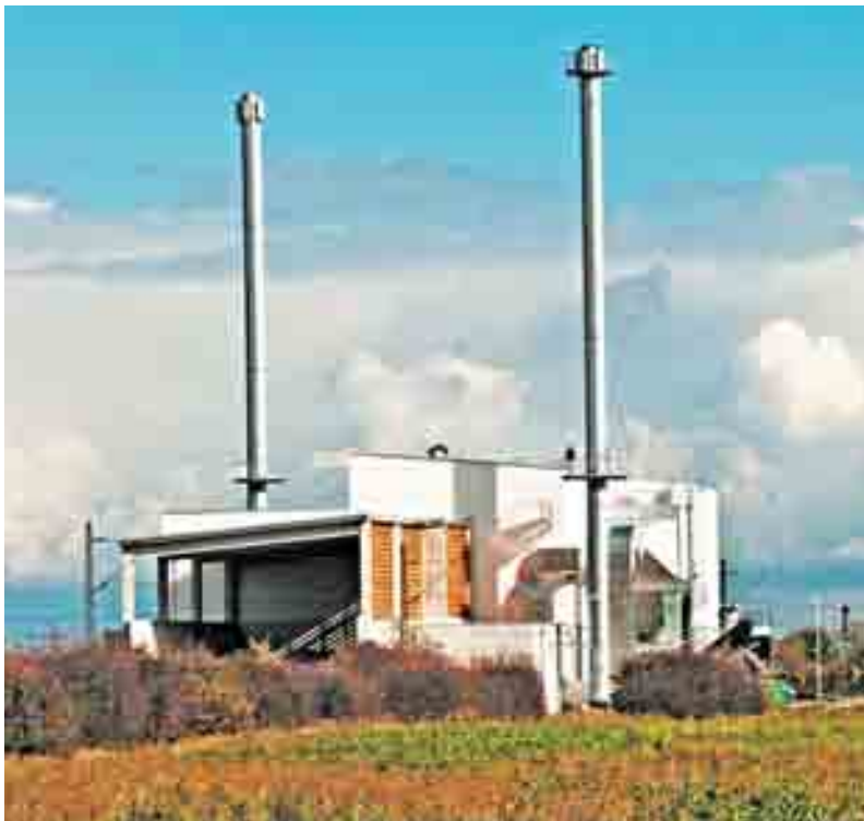
Das Biomasseheizwerk der MVV in Mertingen vermeidet den Ausstoß von beachtlichen 12.700 Tonnen Kohlendioxid.
