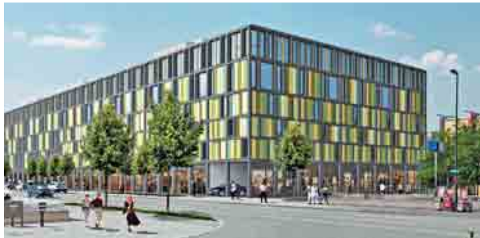
Im Einkaufszentrum in der Pelkovenstraße entsteht auch ein Gesundheitszentrum.
