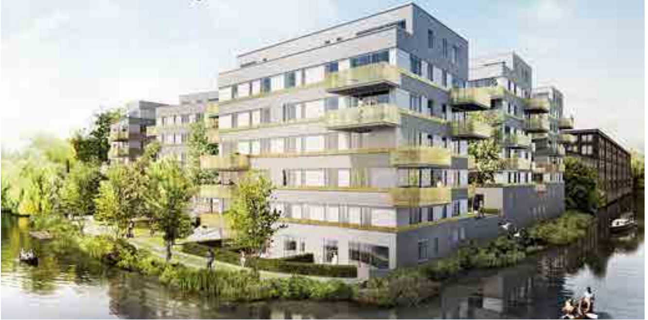
Die Hansaterrassen sollen die Bedeutung von Hamburgs Stadtteil Hamm als citynahen Wohnstandort stärken.
