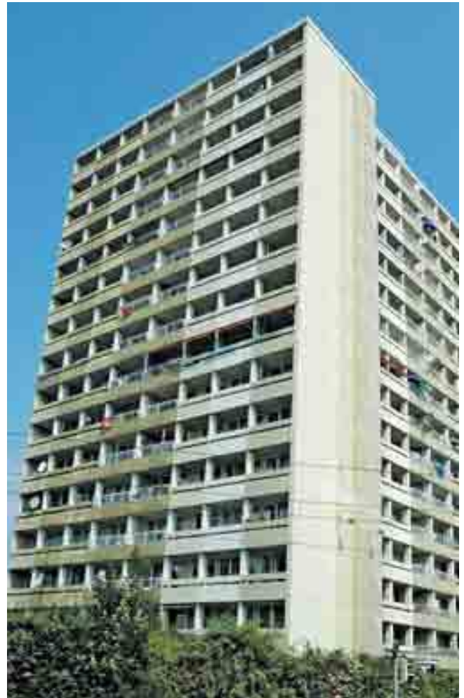
So sah das Gebäude vor der Sanierung aus. Das 40 Jahre alte Haus war schlecht gedämmt, die Grundrisse nicht mehr zeitgemäß.
