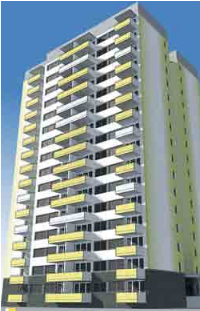
Passivhausstandard. In Freiburg entsteht derzeit der erste energetisch günstige Hochhausbau.
