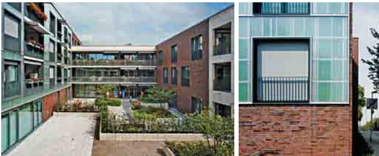
Anlage von Pfeifer Kuhn Architekten, Freiburg im Breisgau. Das Büro hat sich auf kybernetische Gebäude spezialisiert und bereits 2002 ein Produktionsgebäude mit einem wegweisenden Energieeffizienzkonzept realisiert.
