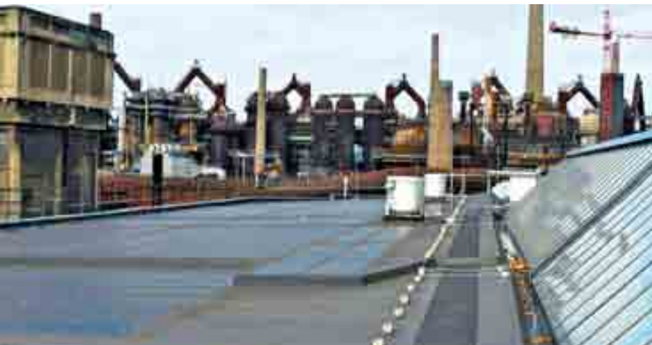
Solardach trotz Denkmalschutz: Das ehemalige Eisenwerk Völklinger Hütte.
