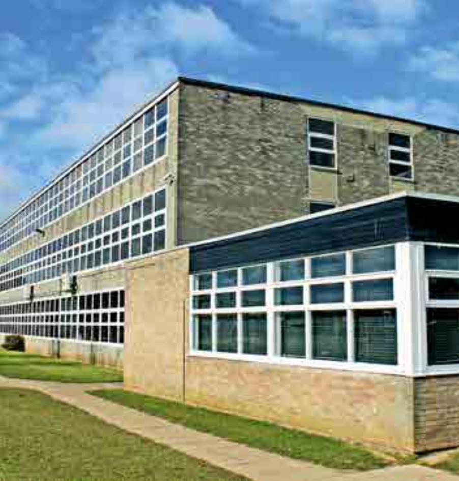
Unsanierete Schulen. Die Erstausrüstung an Fenstern, Fassade und Gebäudetechnik entspricht oft nicht mehr den heutigen Anforderungen an Energieeffizienz.
