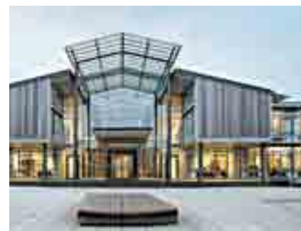
An Gebäuden des Finanzdienstleisters KGAL wurde das neue System getestet.
